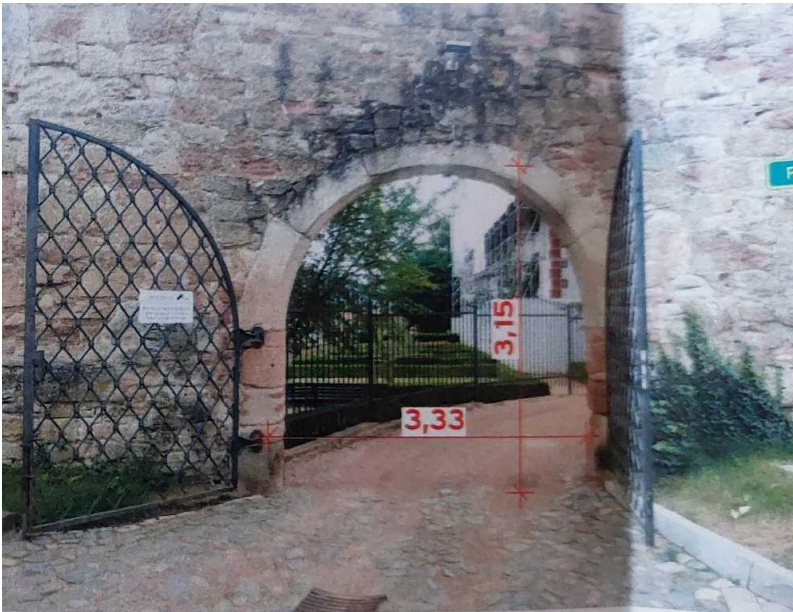
Abb.02: Zufahrt von Osten - Walrabstraße - Torportal 2 Ost (I.B2 Grundstück STSG)
