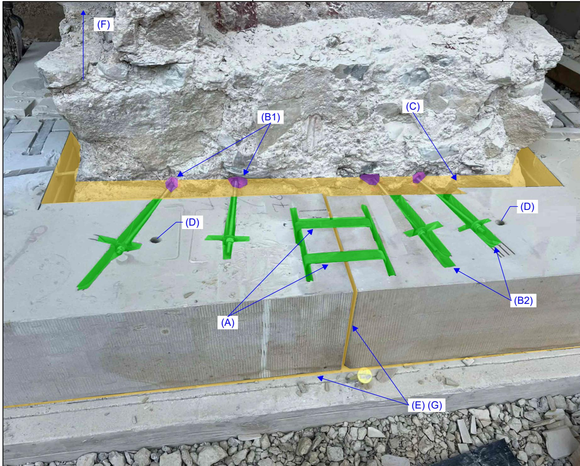
(E) Lagerfugen und Stoßfugen zwischen den Sandsteinen sind vollflächig mit Restaurierungsmörtel HSM 5 von Tubag, hoher Sulfatwiderstand, Druckfestigkeit  $5\text{N/mm}^2$  auszuführen; An den Außenseiten/ Sichtseiten sind die Fugen um 15 mm bis 25 mm zurückliegend auszuführen, für die finale Deckverfugung
