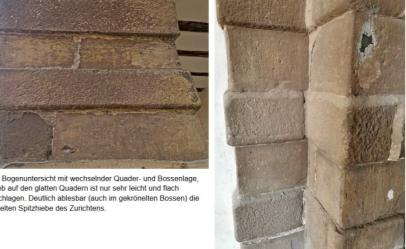
Abb. 4 Bogenstein mit wechselseitiger Quader- und Bossenlage. Der Hieb auf den glatten Quadern ist nur sehr leicht und flach eingeschnitten. Deutlich ablesbar (auch im gekrümmten Hieb) die vereinzelten Spitzhiebe des Zunchesters.
