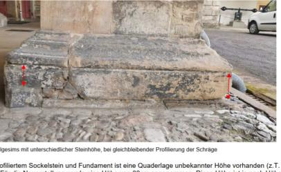
Abb. 6 Sockelgesims mit unterschiedlicher Steinheight, bei gleichbleibender Profilierung der Schrägen. Zwischen profiliertem Sockelstein und Einkerbung ist eine Quaderlage unbekannter Höhe vorhanden (z.T. unter FOK). Für die Neuerstellung wurde eine Höhe von 30cm angenommen. Diese Höhe ist je nach Höhe Betonfundament / Pflasteranschluss etc. frei anzupassen.
