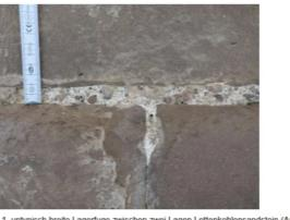
Abb. 1 untypisch breite Lagerfuge zwischen zwei Lagen Letteneckensandstein (Ausgleichsfuge), Stoßfuge = Pressfuge
