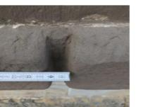
Abb. 3 Scheinfuge im Bestand mit typischer Breite = 4cm
