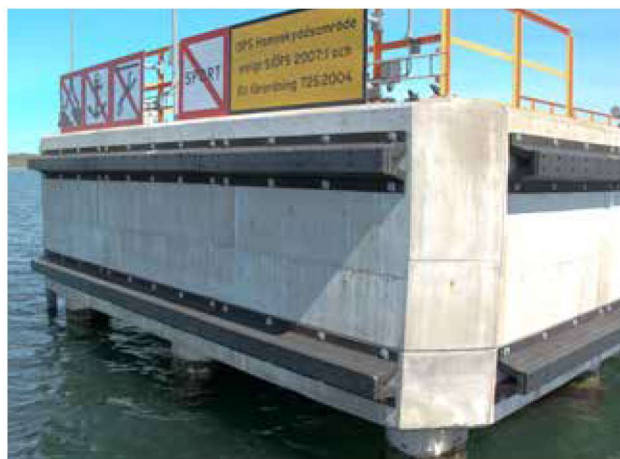
Ethanol Jetty | Stenungsund | Sweden
