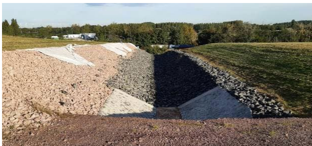
Abb. 11: Entwässerungsgraben Ost im Übergang zum Raubettgerinne Steilböschung Nord
