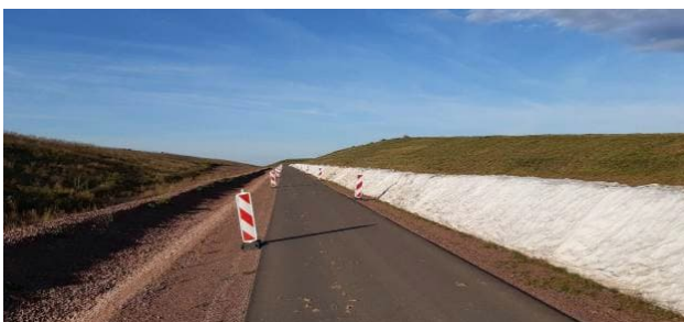
Abb. 7: vorhandene Straße mit Bankette, Graben, Schotterwall und Schotterkeil (deponieseitig)
