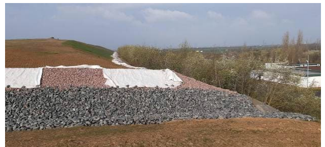
Abb. 12: Entwässerungsgraben Ost im Übergang zum Raubettgerinne Steilböschung Nord
