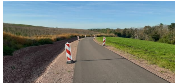
Abb. 10: vorhandene Straße mit Bankette, Graben und Schotterwall
