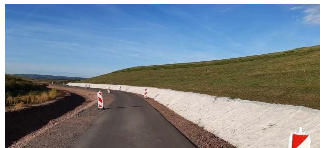
Abb. 8: vorhandene Straße mit Bankette, Graben, Schotterwall und Schotterkeil (deponieseitig)
