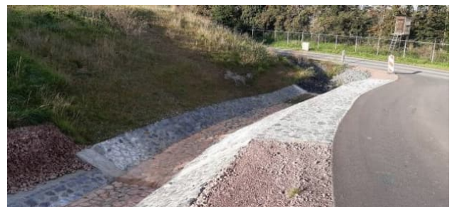
Abb. 16: Einlaufbereich Durchlass 2
