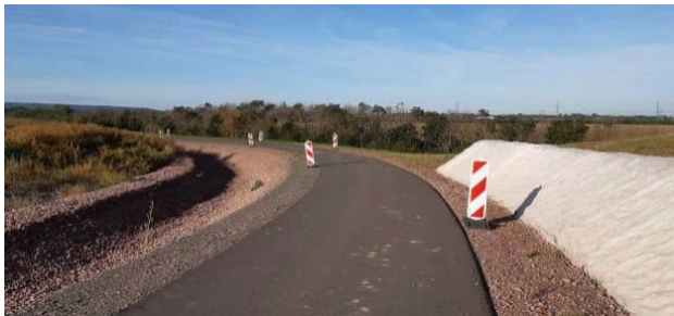
Abb. 9: vorhandene Straße mit Bankette, Graben, Schotterwall und Schotterkeil (deponieseitig)
