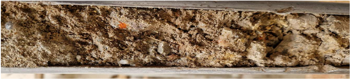
Bild 8: Auffüllung in der Sonde
