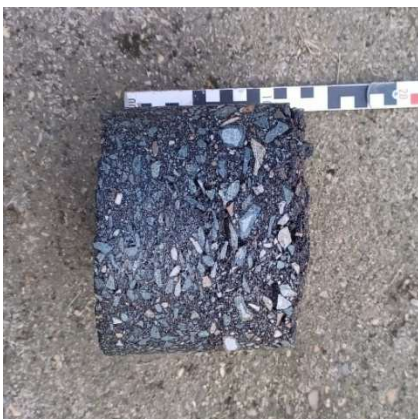
Bild 3: Asphaltkern an BS 1/25
