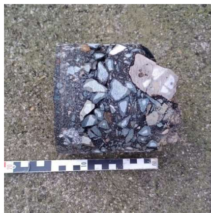
Bild 4: Asphaltkern an BS 2/25
