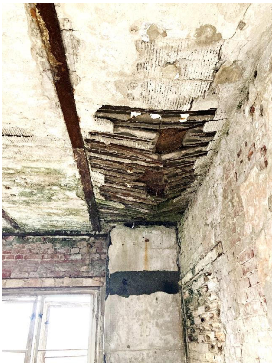
Abbildung 4 – eingebrochenes Deckenfeld
