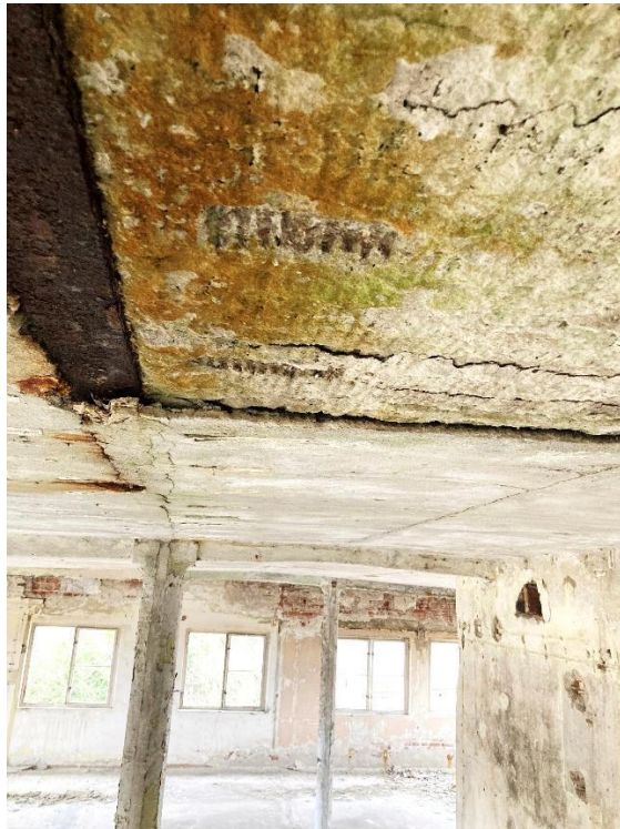
Abbildung 6 – Ablösung Betonspiegel Hohldiele
