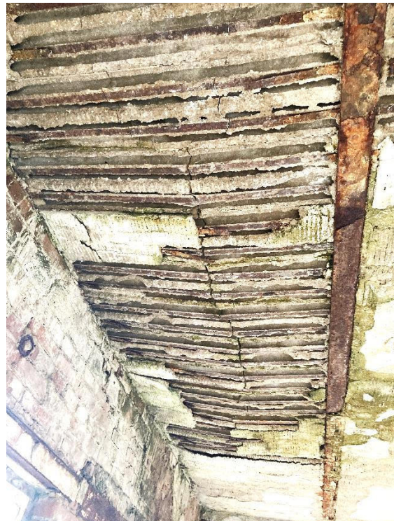
Abbildung 5 – gerissene Bewehrung
