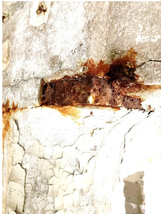
Abbildung 10 – oberflächlicher Rost, Stützenkopf
