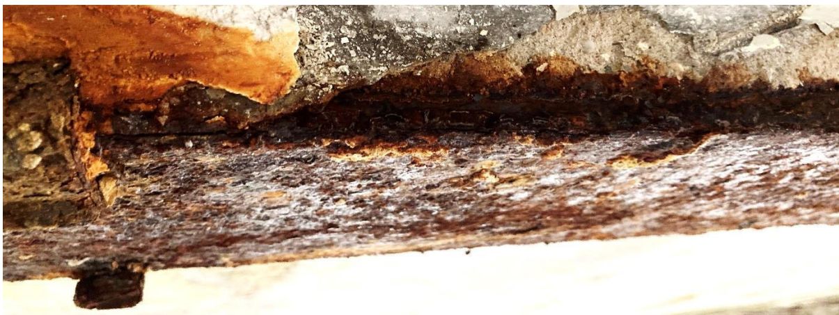
Abbildung 8 – Hauptträger, starke Abrostung, Abplatzung
