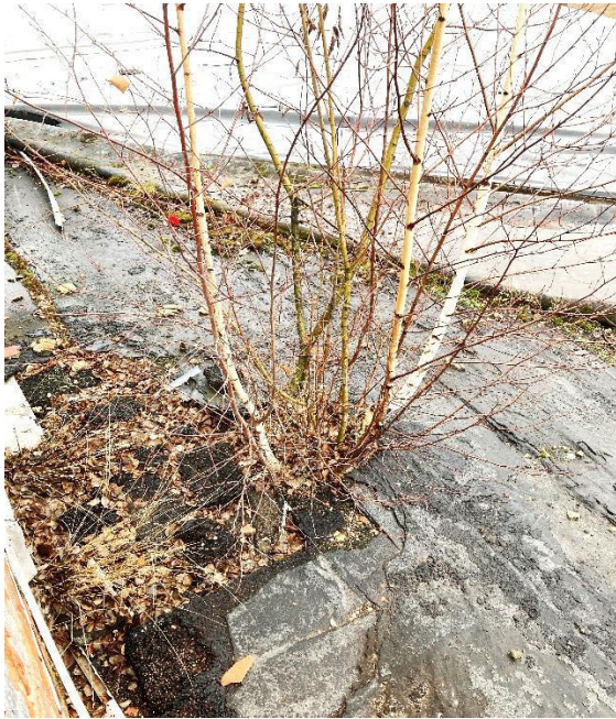
Abbildung 3 – zerstörte Abdichtung, Vegetation
