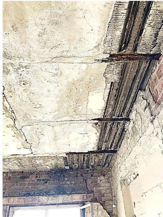
Abbildung 7 – Rissbild deutet auf Korrosion hin
