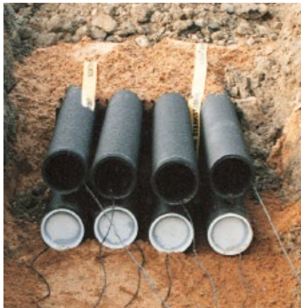
Kabuflex S – richtungsgebende Abstandhalter machen die Verlegung sicher und schnell
