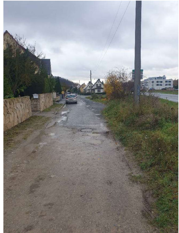
Blick aufs Baufeld Straße Marienberge nach Süden
