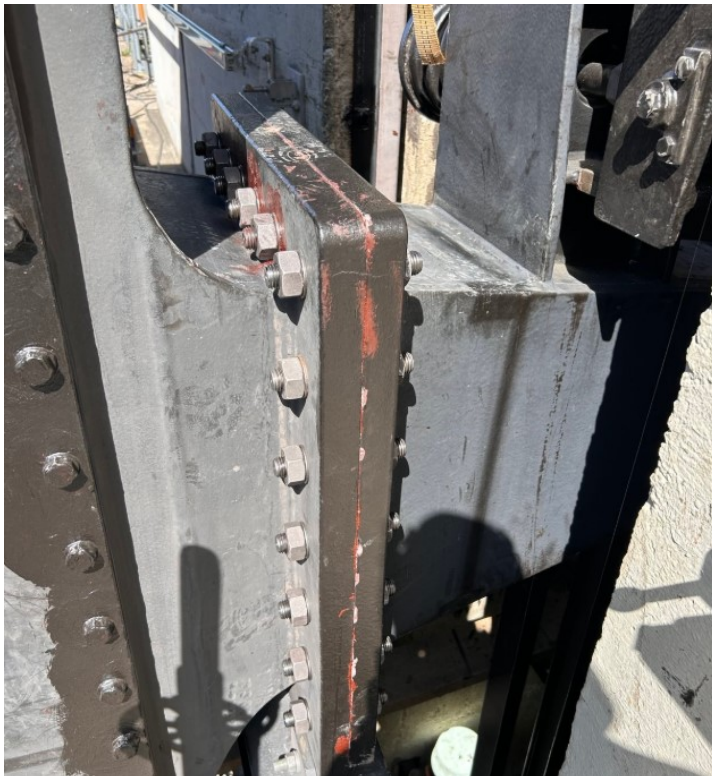
Bild 2: Verbindung Torarm – Obertor Schleuse Forchheim
