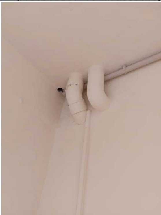
links sml, kann zurück gebaut werden Rechts TW mit Dämmung 25.06.2025
