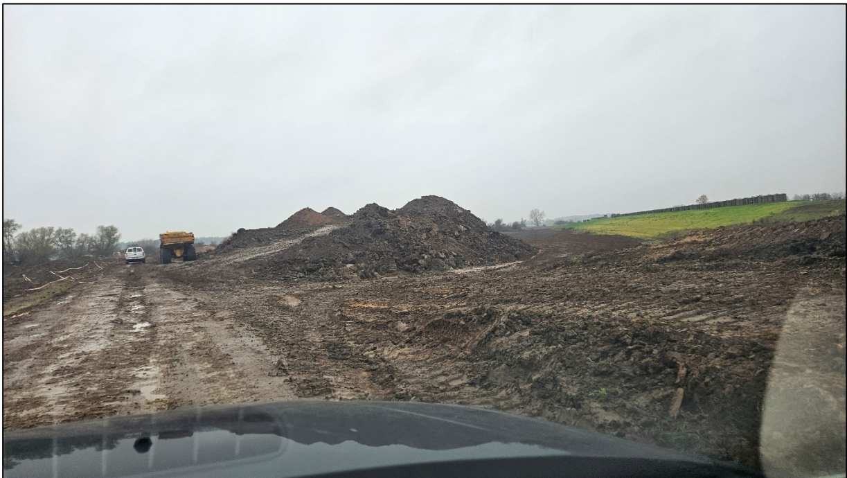
Abbildung 6: Bodenlager am Bauabschnittsende
