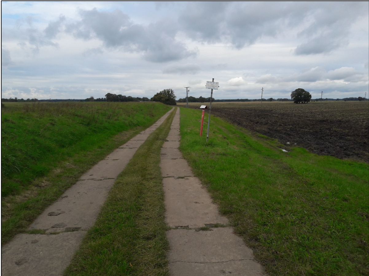
Abbildung 3: Deich-km 12,00 mit Blick nach Westen, Querung Oelpipeline (Bildmitte) und Energiefreileitung (Bildhintergrund) [Quelle: PPN, 09/2017]
