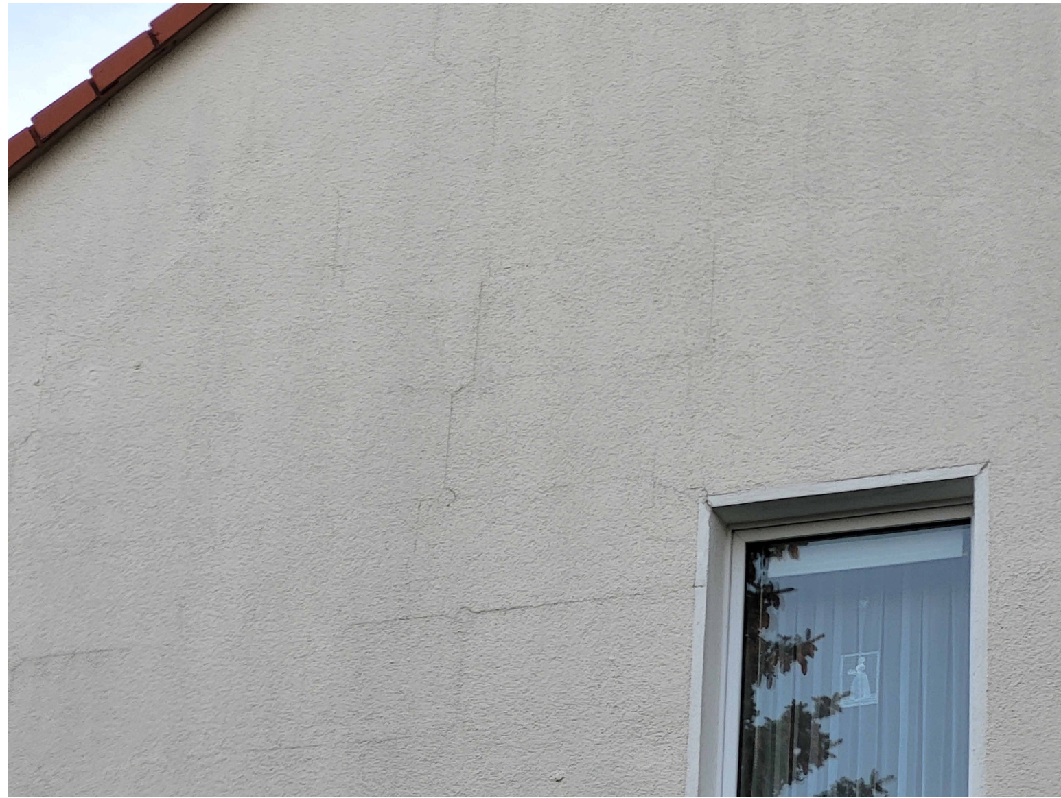
Detail: sichtbares Fugenbild Fassade, oberer Bereich
