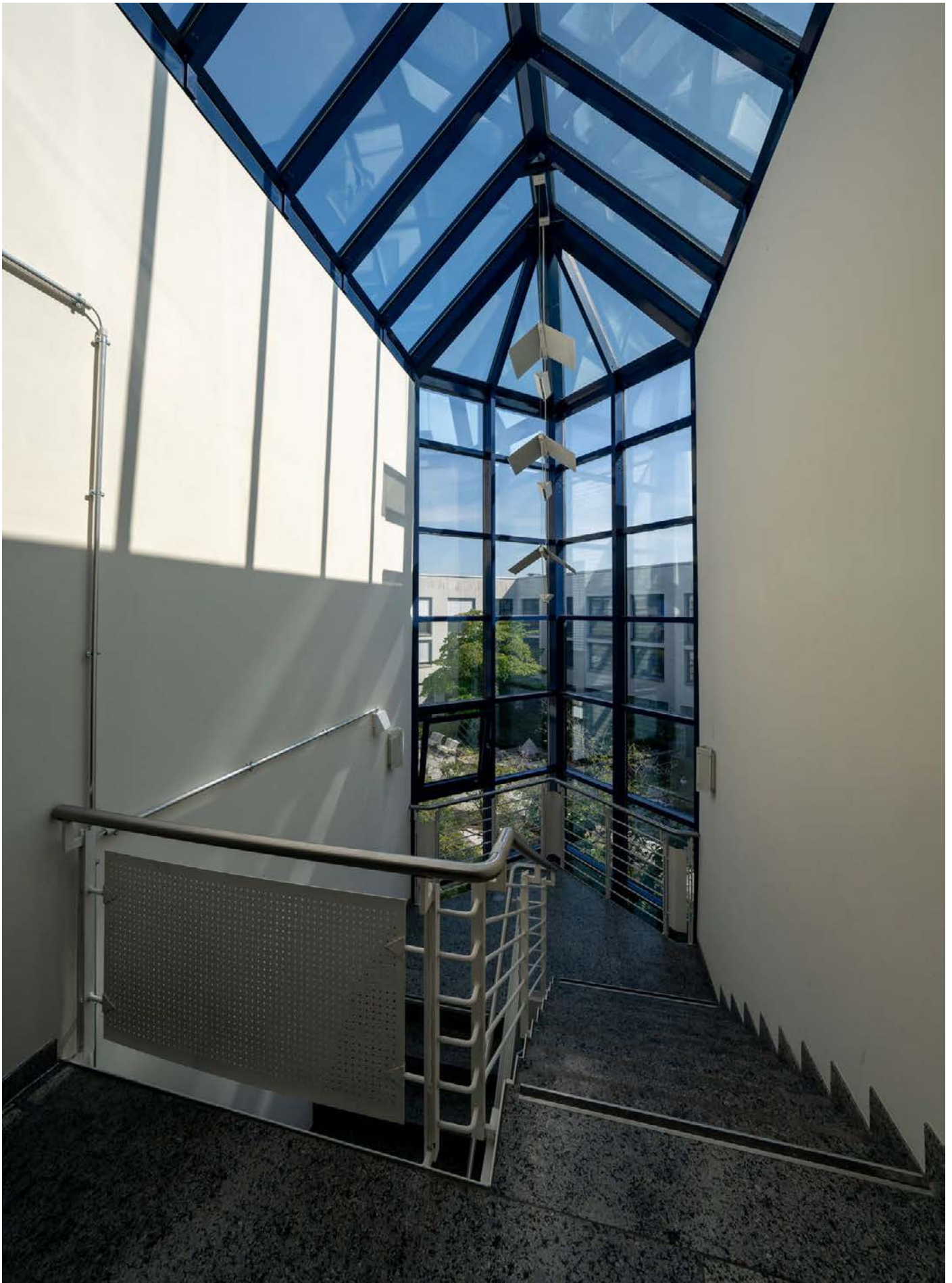
Ansicht Treppenhaus Kern mit Sonderleuchte
