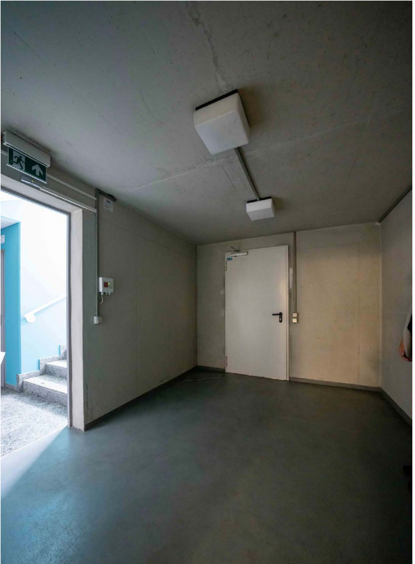
Beispiel Ansicht Vorraum Treppenraum KG
