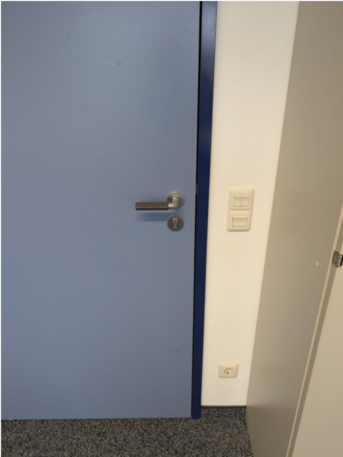
Ansicht Zugang Büro mit Bestandsschalter
