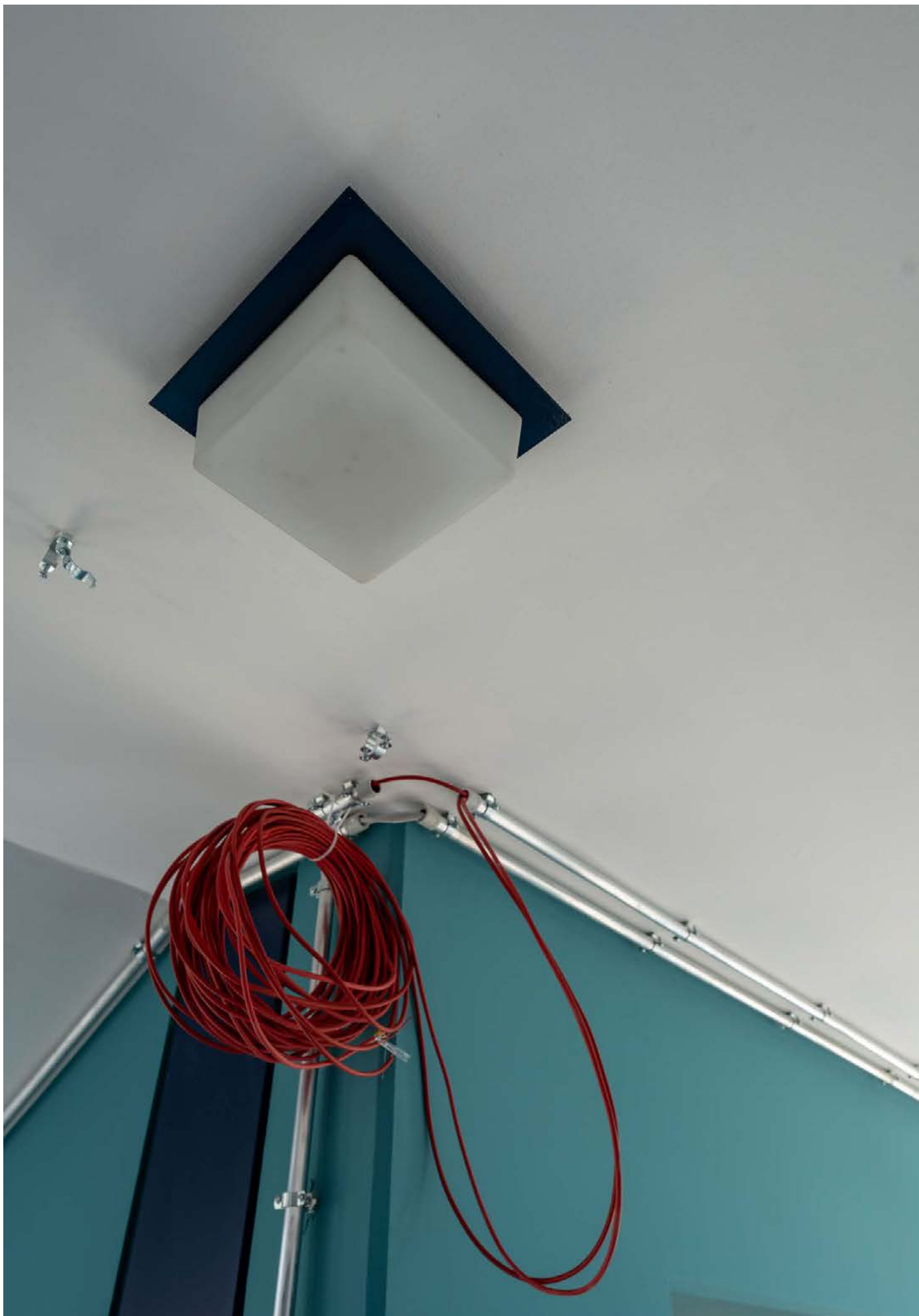
Ansicht Bestandsleuchten Decke äußere Treppenhäuser
