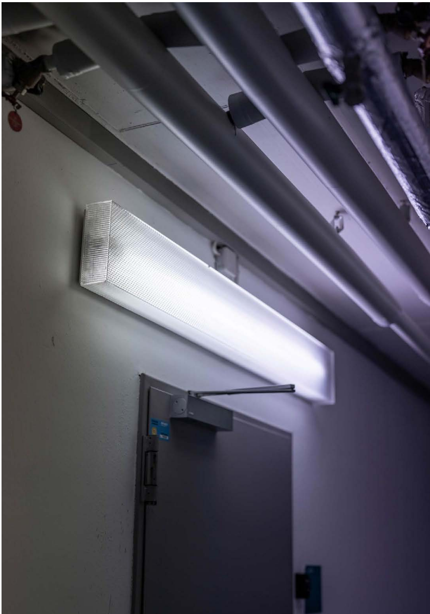
Ansicht Bestandsleuchte Wandmontage Flur KG
