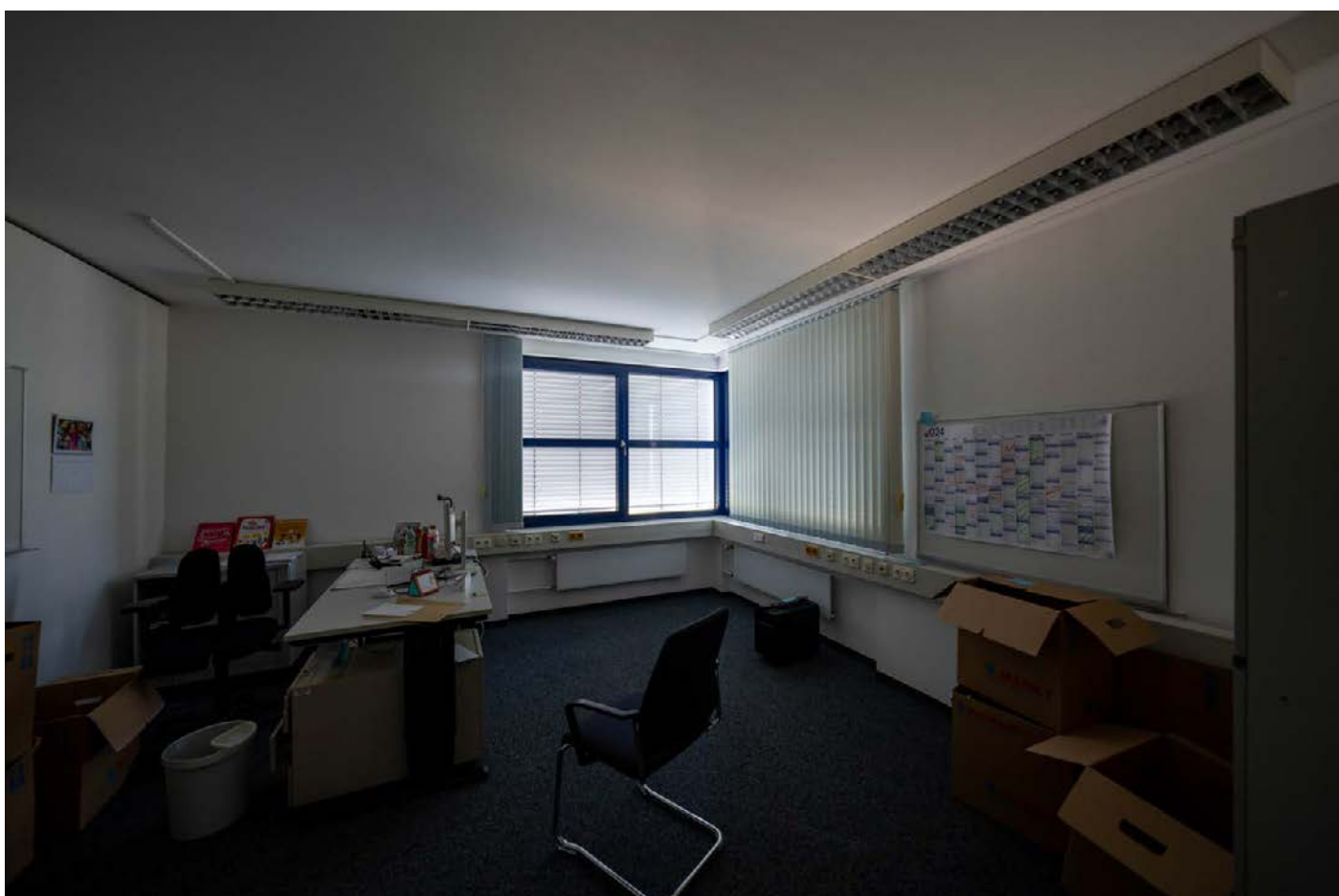
Ansicht Büro mit Beleuchtung Typ Aufbauleuchte
