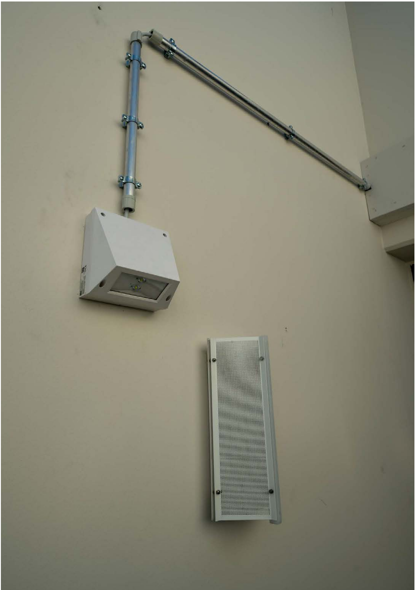
Ansicht Leuchte Treppenhaus Bestand mit Sicherheitsbeleuchtung neu
