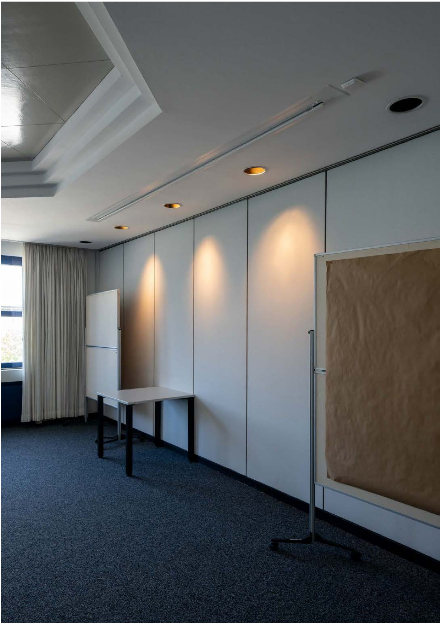
Ansicht Spotbeleuchtung Randbereich
