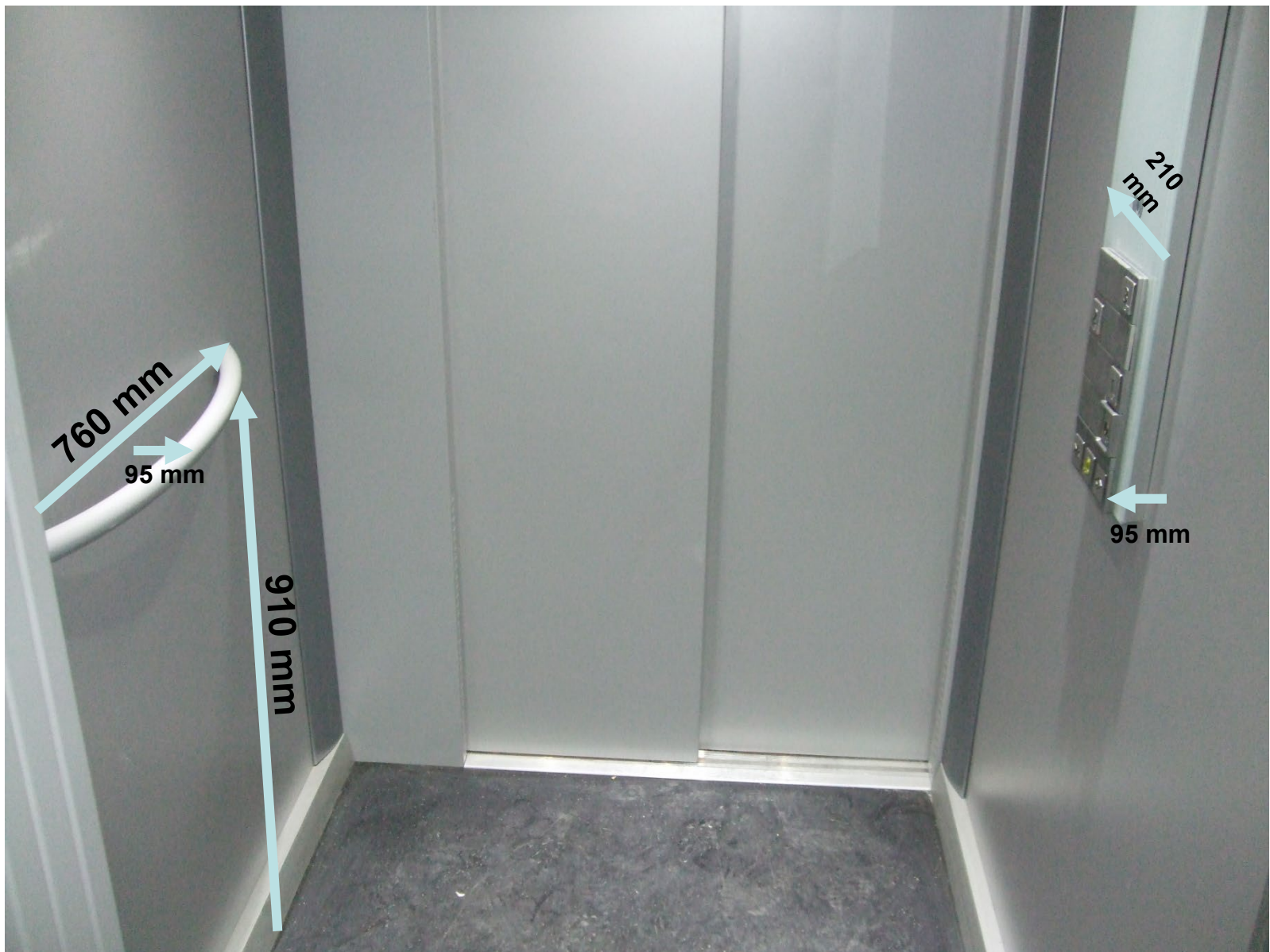
Personenaufzug mit Handlauf (nicht zu demontieren) Kabinenmaß: B 1,20 x T 1,40 x H 2,14 m
