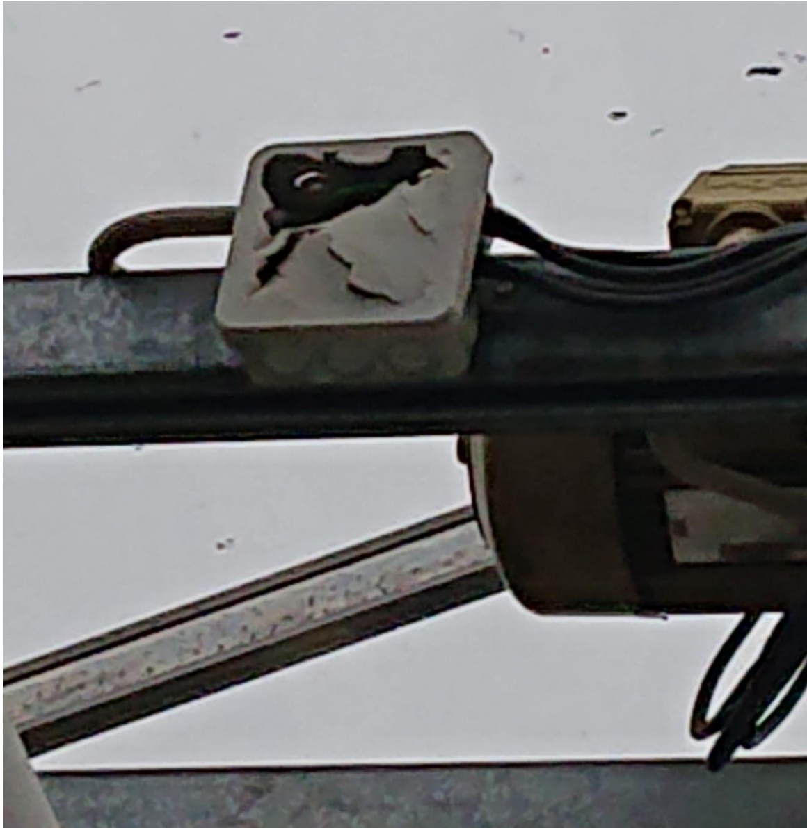
Abbildung 12: Verschlissene Verteilerdose im Dachbereich
