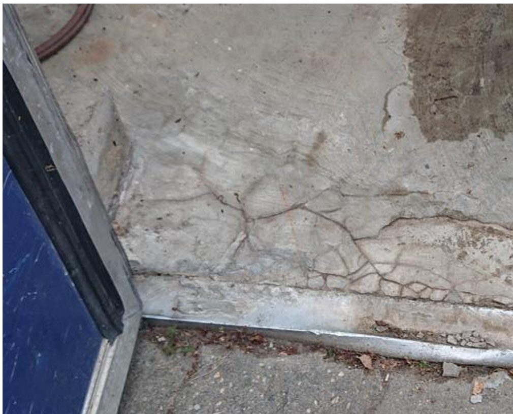
Abbildung 3: Abplatzungen und Rissbildung in der Bodenplatte Arbeits- und Technikraum
