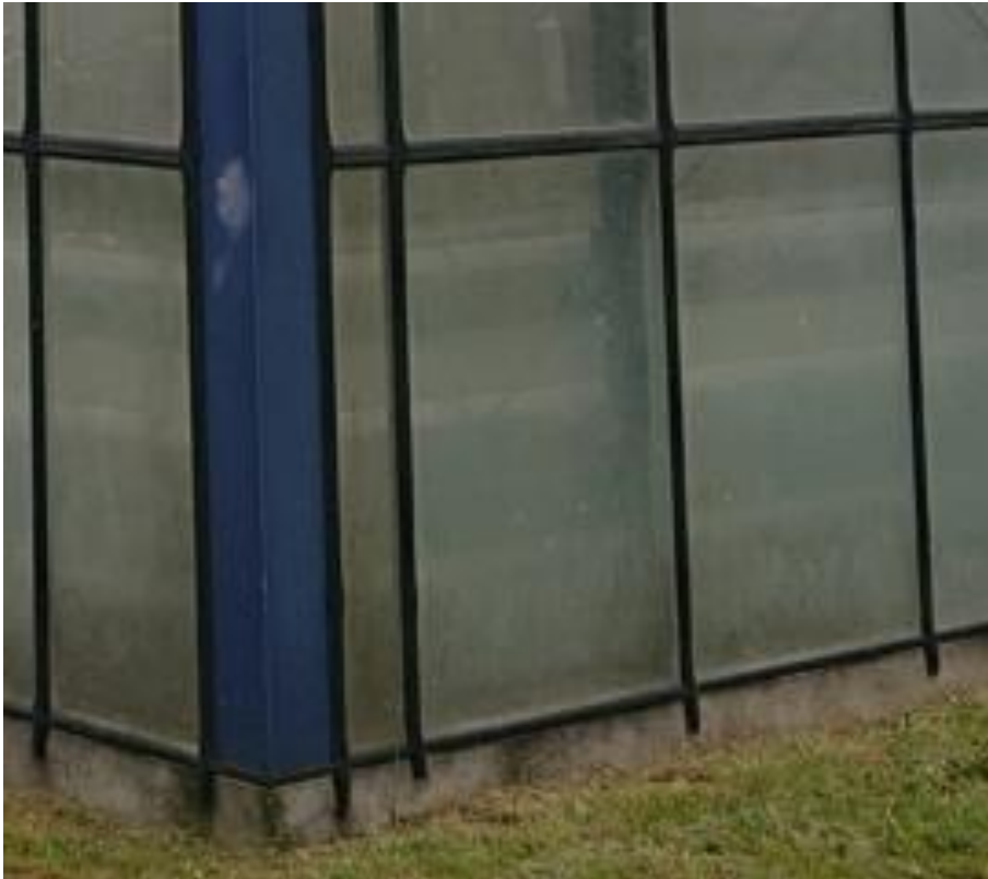
Abbildung 5: Gummiabdeckprofile an der Außenwand-Verglasung
