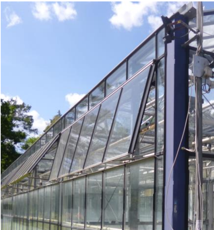
Abbildung 6: Stehwand-Lüftungsklappen der Kabinen
