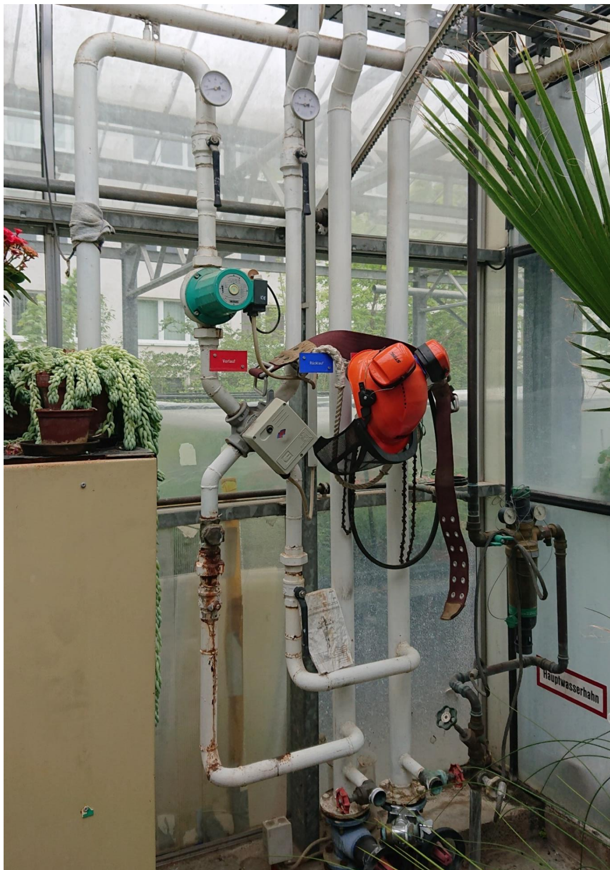
Abbildung 11: Technisch verschlissene Pumpe-Mischer-Baugruppe
