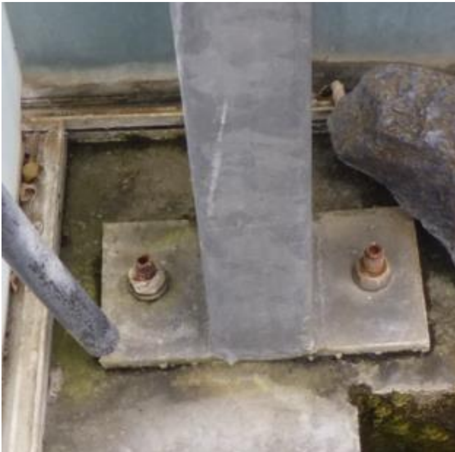
Abbildung 8: Verschraubung der Stahlskelettkonstruktion auf der Bodenplatte
