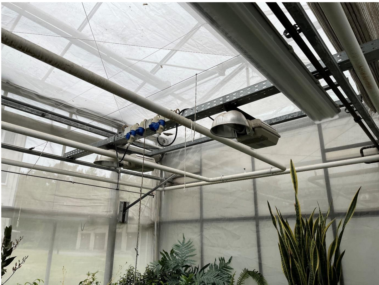
Abbildung 13: Veraltete und technisch überholte Assimilationsbeleuchtung
