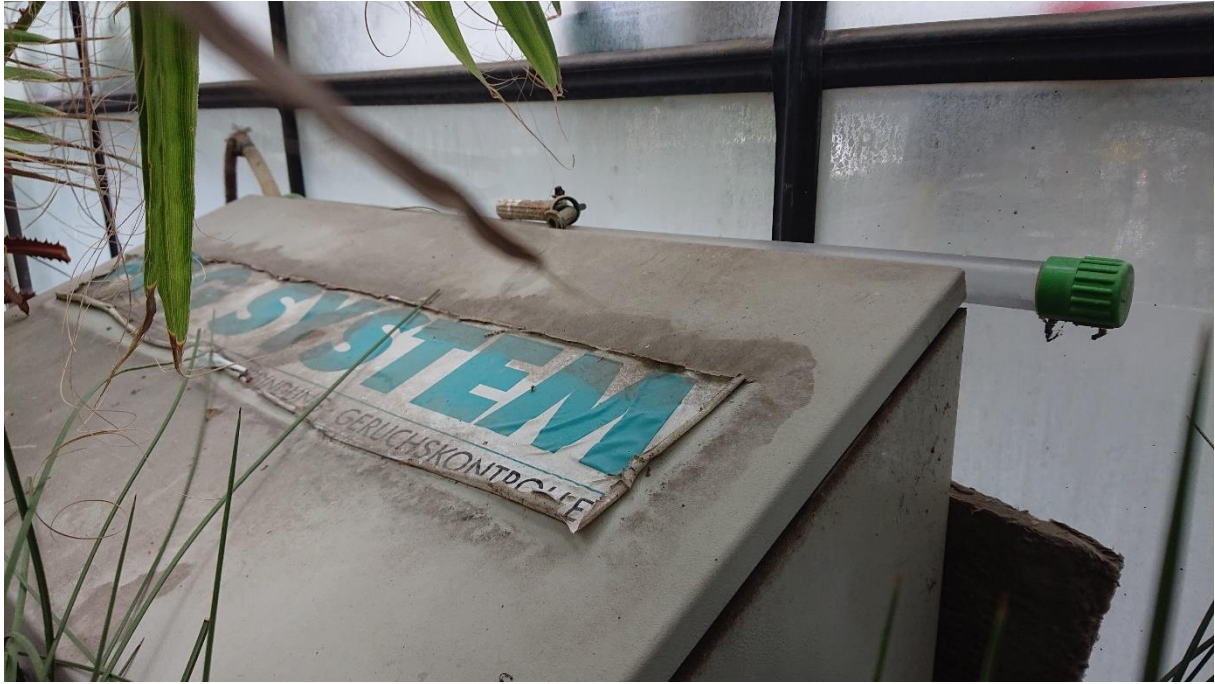
Abbildung 10: Aktuelle Hochdruck-Nebelanlage (Außer Betrieb)
