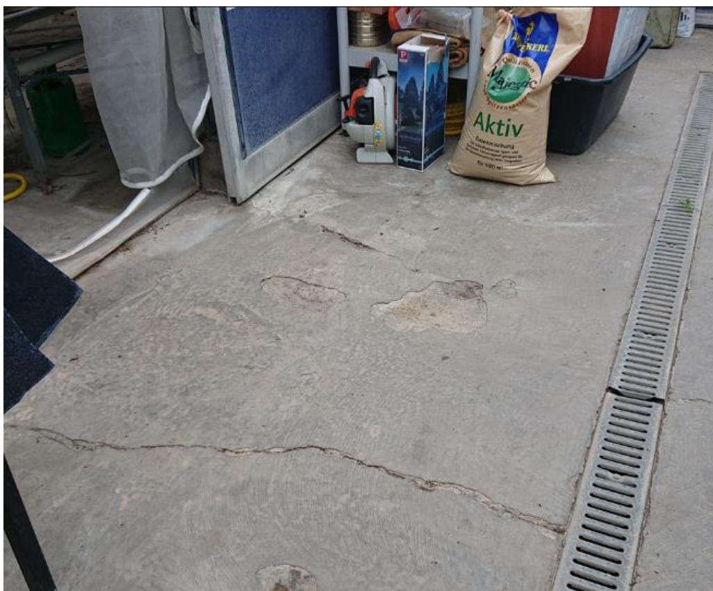
Abbildung 4: Abplatzungen und Rissbildungen der Bodenplatte im Arbeitsverbinder
