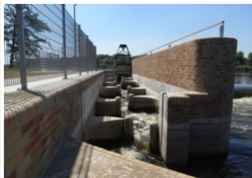
Abb. 5.2-1: Herstellung der Durchgängigkeit durch einen technischen Beckenpass
