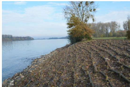
Abb. 7.3-1: Einbau von Weidenspreitlagen als Ufersicherung
