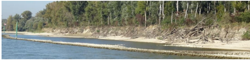
Abb. 7.2-1: Eigendynamische Entwicklung von Uferstrukturen hinter teilweise rückgebauter Ufersicherung
