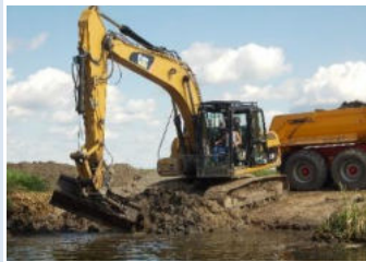
Abb. 2.1-1: Rückbau einer Buhne aus Wasserbausteinen
