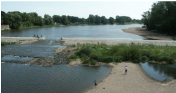
Abb. 5.1-1: Schleifung eines Querbauwerkes
