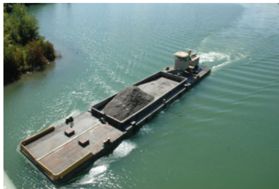
Abb. 1.5-1: Regelmäßige Sedimentzugabe im Rahmen der Unterhaltung
