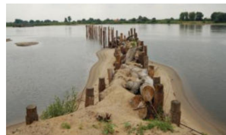
Abb. 2.2-2: Totholzbuhne als alternativ technisch-biologisches Regulierungsbauwerk
