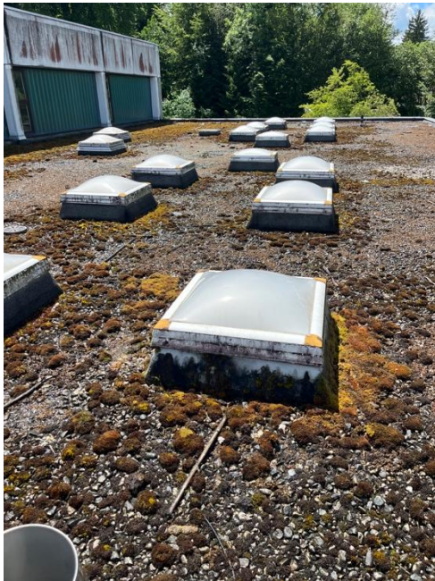
Foto 03: Dachfläche, Turnhalle – Blickrichtung Osten
