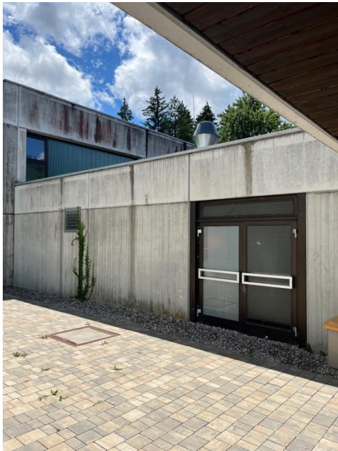
Foto 01: Attika-Anschlussbereich zur Dachfläche, Turnhalle
