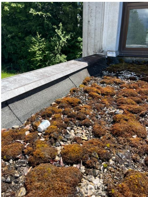
Foto 04: Anschluss, Aufkantung – Dachfläche an Attika
