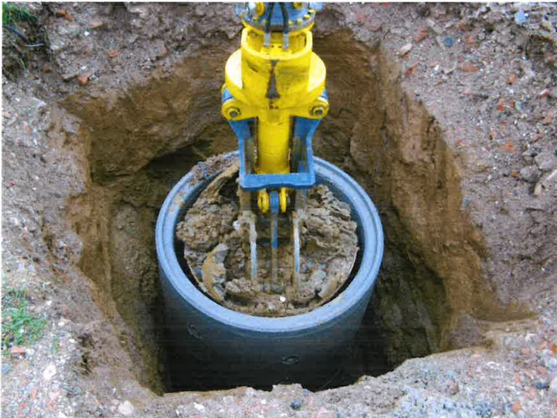
Abbildung 1: Herstellung einer Brunnengründung
