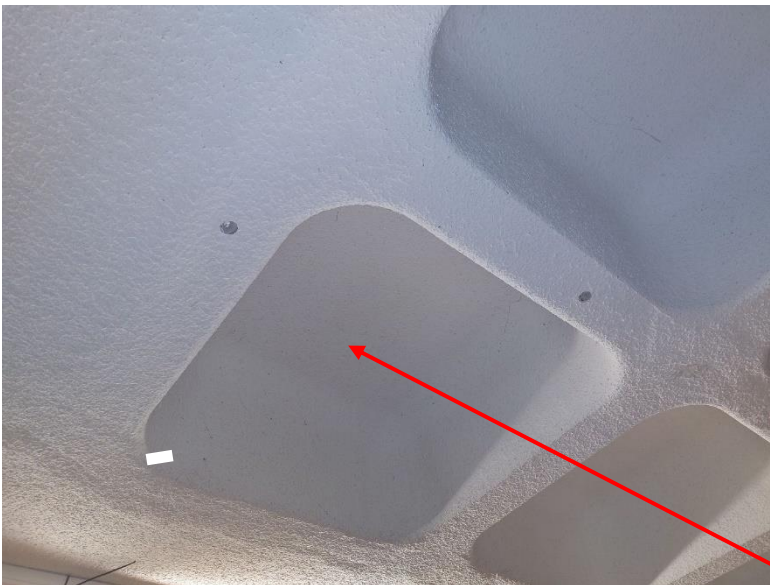
Bild 4: Decke UG, Schalldämmender Putz / Spachtel auf Beton, Probe M25: asbestfrei
