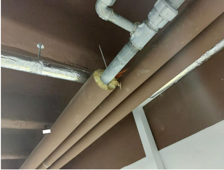
Bild 1: Rohrleitungen mit Mineralwolledämmung
