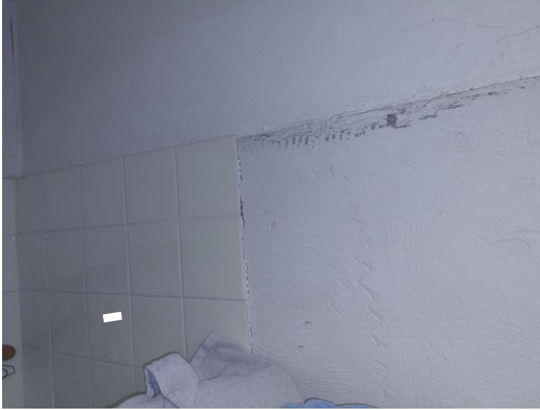
Bild 5: WC-Bereich – Wandfliesen, Probe M26 (Fliesenkleber Zahnpachtel): asbestfrei
