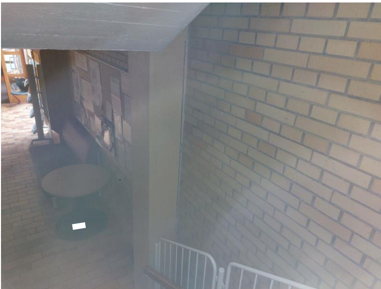
Bild 12: Anschlussfuge Stütze, Probe M39, PCB <Best.Gr.
