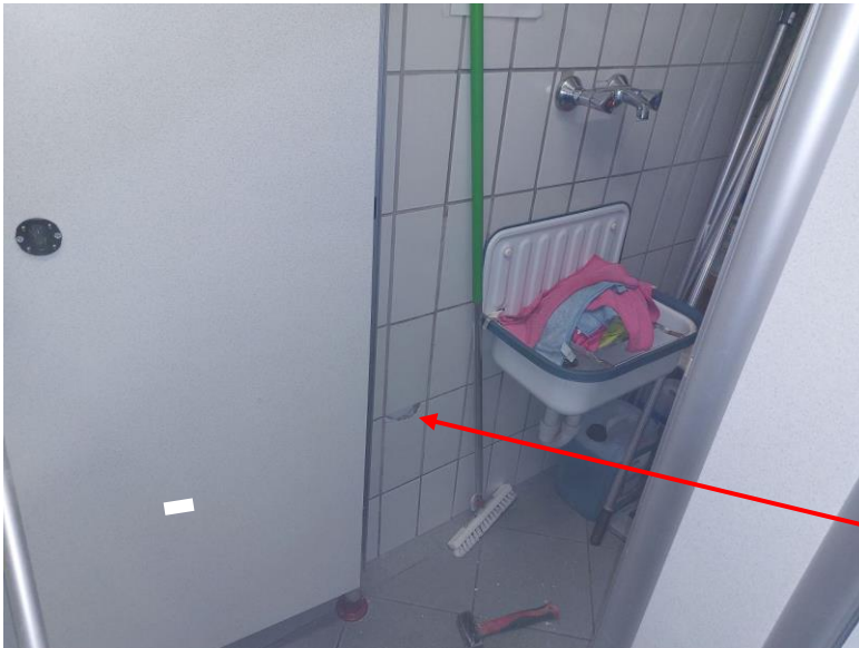
Bild 2: WC-Bereich (exemplarisch) – Wandfliesen, Probe MP2 (Fliesenkleber Zahnpachtel): asbestfrei
