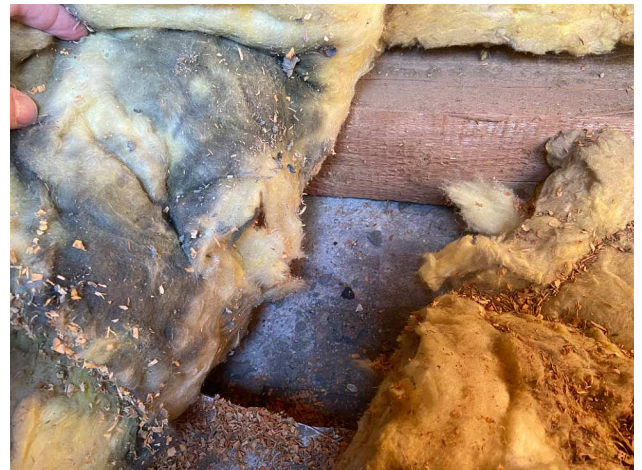
Bitumenhaut wurde entfernt
