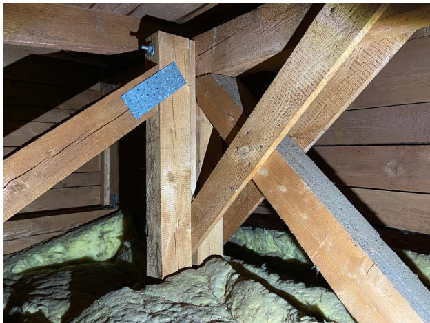
ehemaliges Flachdach, Mineralwolle
