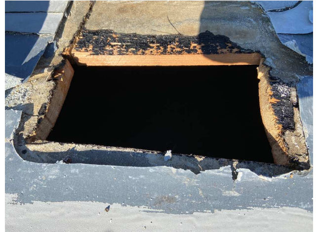
Bitumen auf Holzdecke
