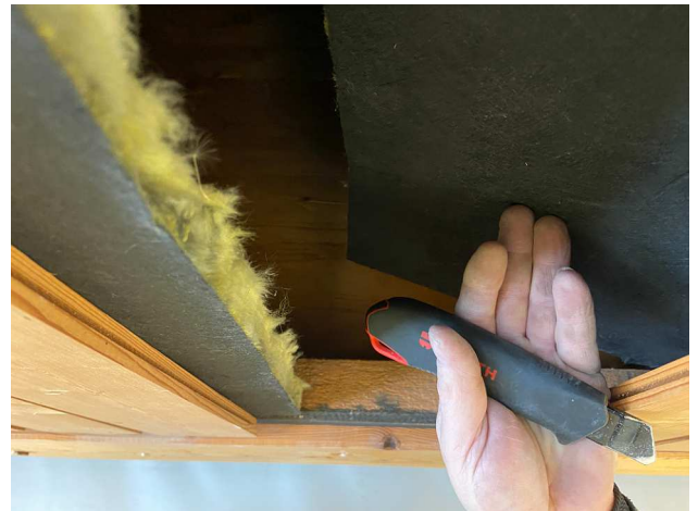
Deckenöffnung Mineralwolle auf Flies
