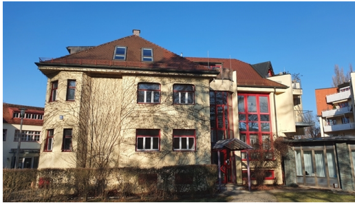
Ostansicht Bauteil E vor Abbruch
