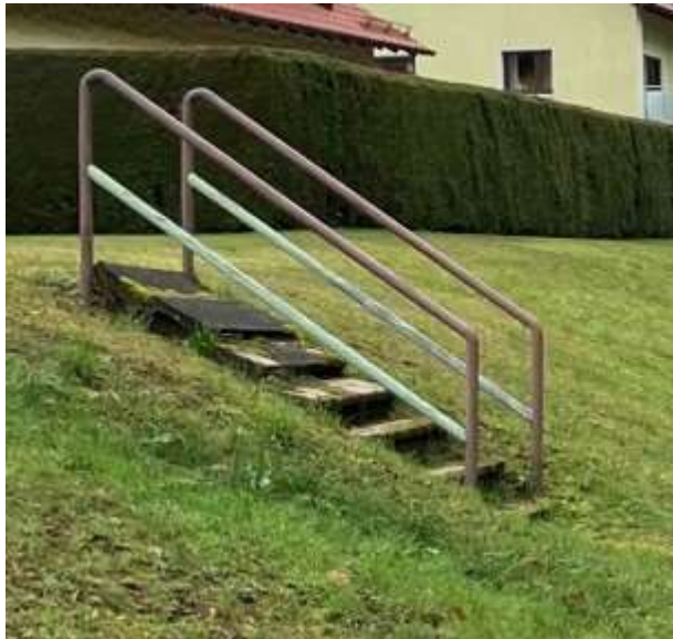
Abbruchmaterial in Eigentum des AN übernehmen und von der Baustelle entfernen.
