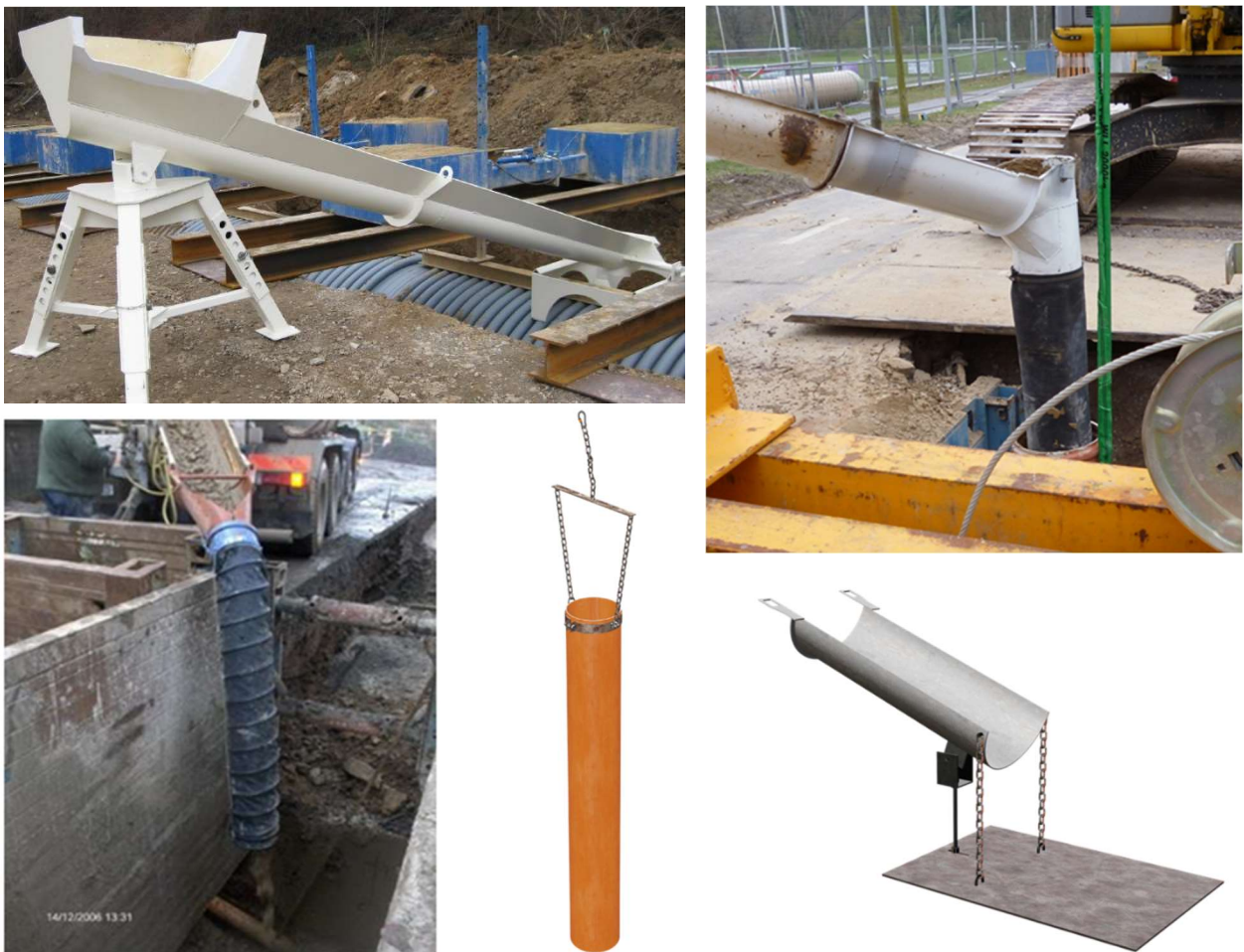
Abbildung 4: Beispiele von technischen Hilfsmitteln zum korrekten Einbau von RSS Flüssigboden entsprechend der technologischen Vorgaben der Fachplanung
