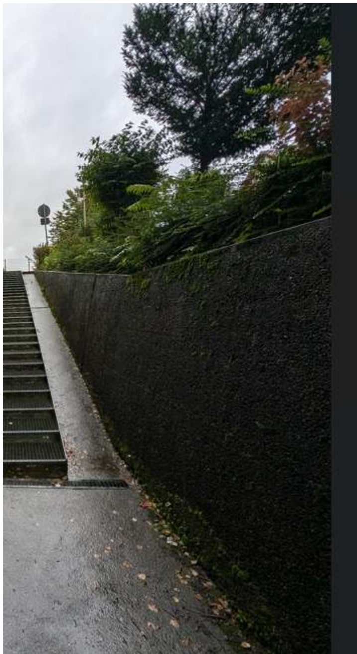
Mauer von unten
