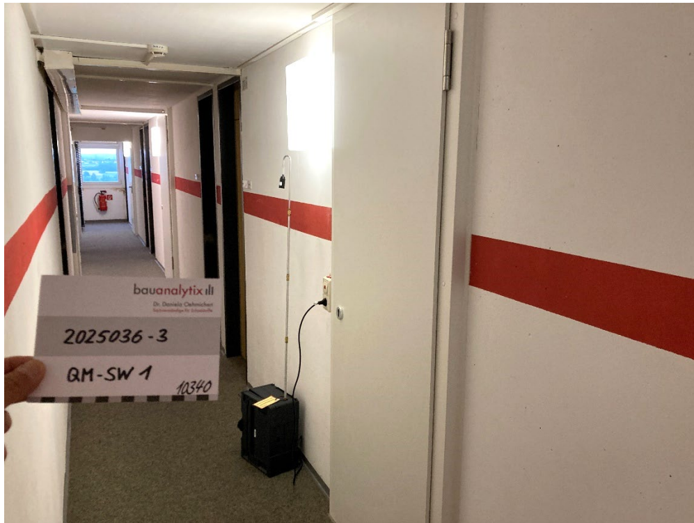
Bild 1: Messpunkt QM-SW 1, OG13, Flur 1 vor Technischacht Zimmer 9 und 19
