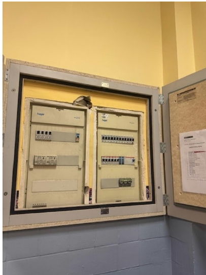
UV EG. Flur Nebengebäude
