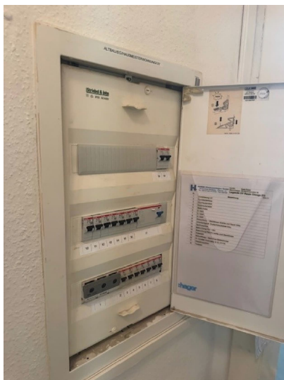
UV EG. OGS Nebengebäude
