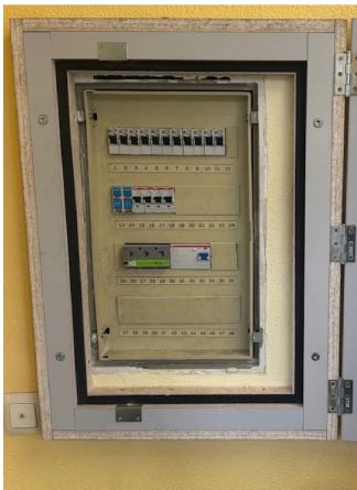
UV 1.OG. Flur Hauptgebäude
