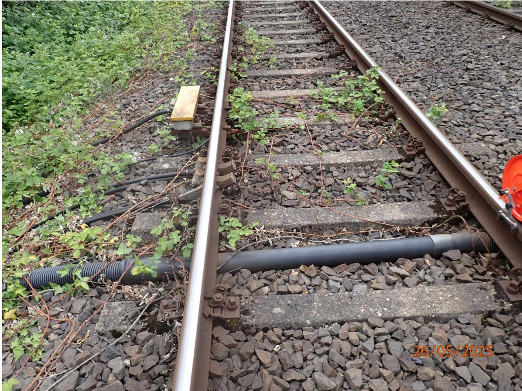
Bild 9: Querung PVC Schwellenfach km 8,439
