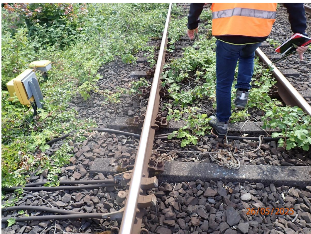
Bild 2: Az rechts + Querung im Fach + Km Stein 8 0 links + Wanderschutz links km 8,003
