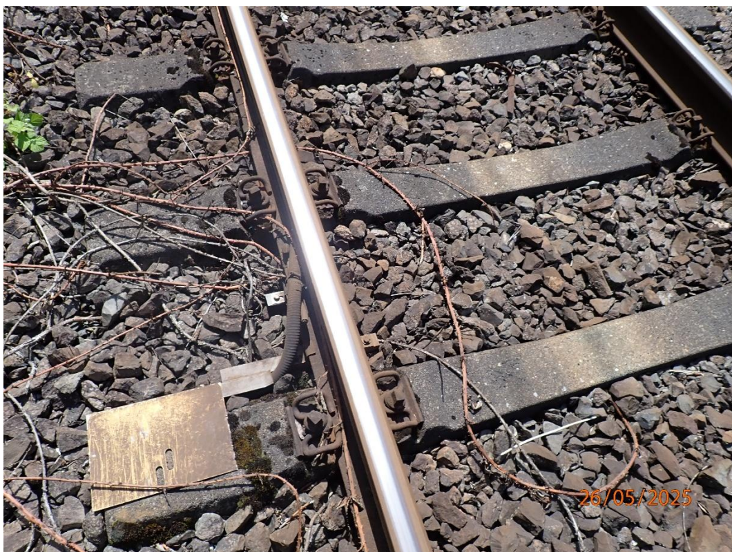
Bild 16: Beginn Schienenfußkabel außen km 9,863
