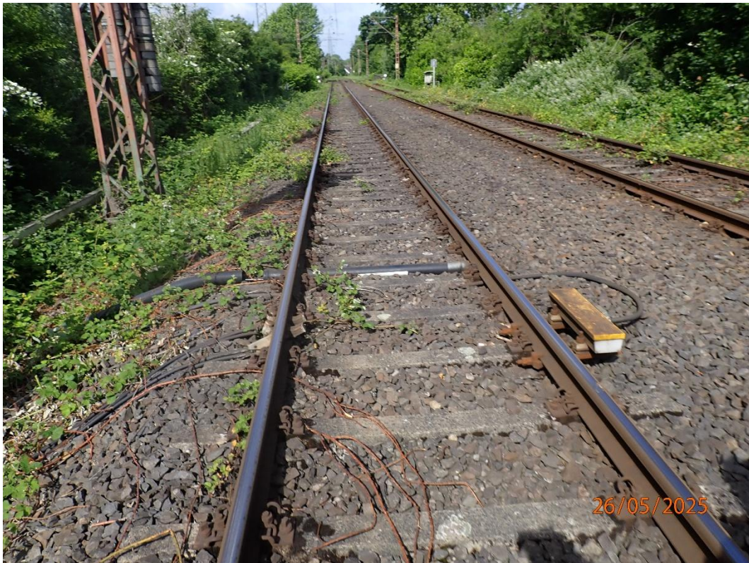
Bild 11: PZB re + Az links + ESig 38FF links + KV links + Querung Schwellenfach km 8,442
