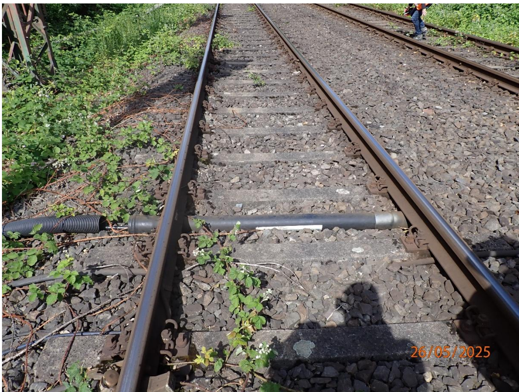
Bild 12: Querung PVC-Rohr LST-Querung km 8,440
