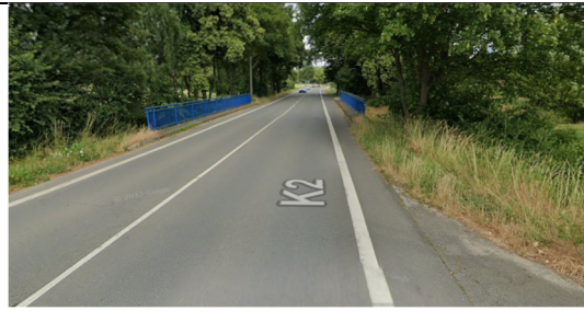
Abbildung 4: Vorh.- Fahrbahnbrücke, R. Westen
