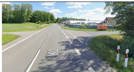
Abbildung 10: Ausbauende, R. Westen
