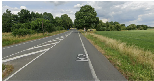
Abbildung 3: Ausbaubeginn, R. Westen
