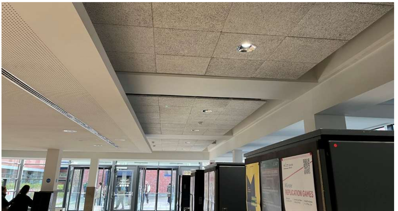
EG Foyer Demontage u. Entsorgung abgehängte Decken
