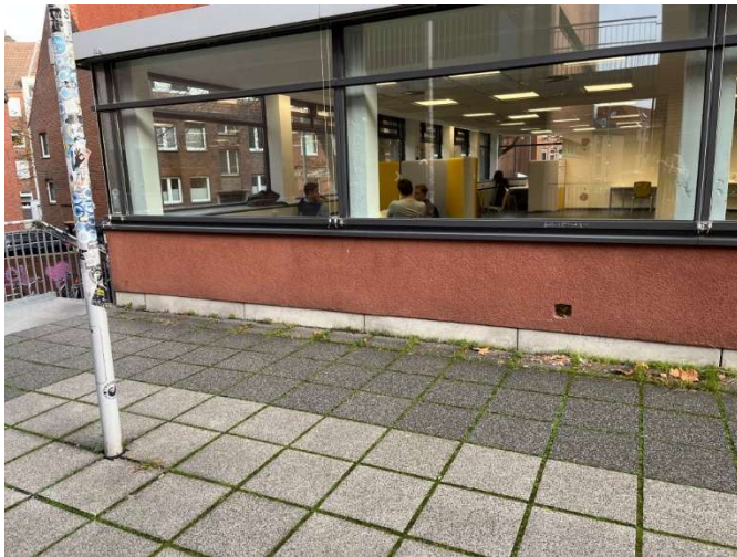
Südfassade - Ausbau und Entsorgung Alu-Glas-Fensterelement, Abbruch Brüstung
