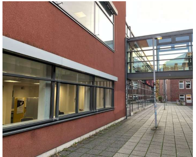
Südfassade - Ausbau und Entsorgung Alu-Glas-Fensterelement, Abbruch Brüstung
