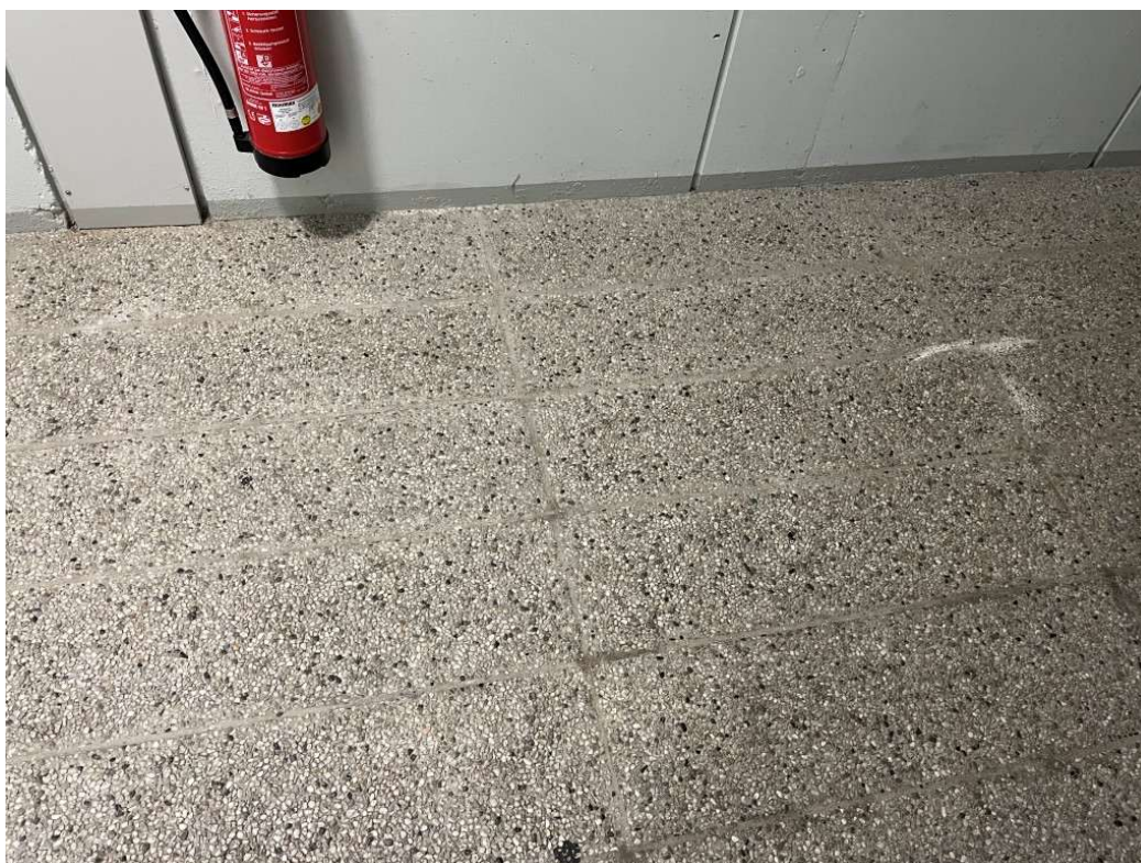
Demontage u. Entsorgung Waschbetonpl. incl. Estrich für neue Wand in F90
