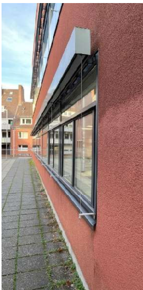
Südfassade - Ausbau und Entsorgung Alu-Glas-Fensterelement, Abbruch Brüstung
