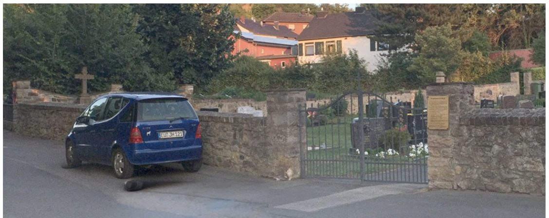
Zustand der Friedhofsmauer vor dem Hochwasserereignis
