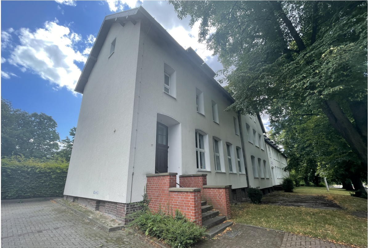
Straßenansicht Waltroper Straße an der nördlichen Zufahrt zum Schulhof
