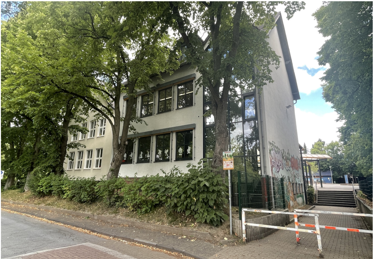
Straßenansicht Waltroper Straße (Stichstraße in Richtung Tennisplätze und Friedhof)
