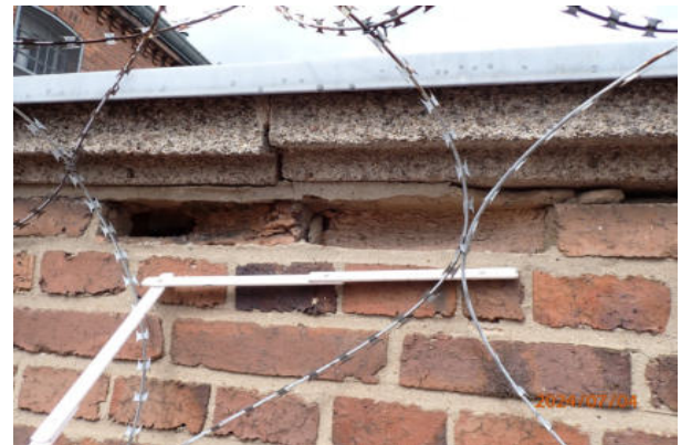
2. Mörtelfuge schadhaft
