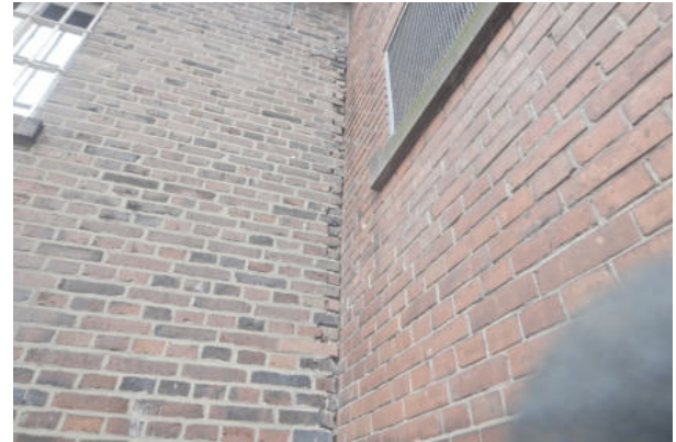
2. Abplatzung an Mörtelfuge
