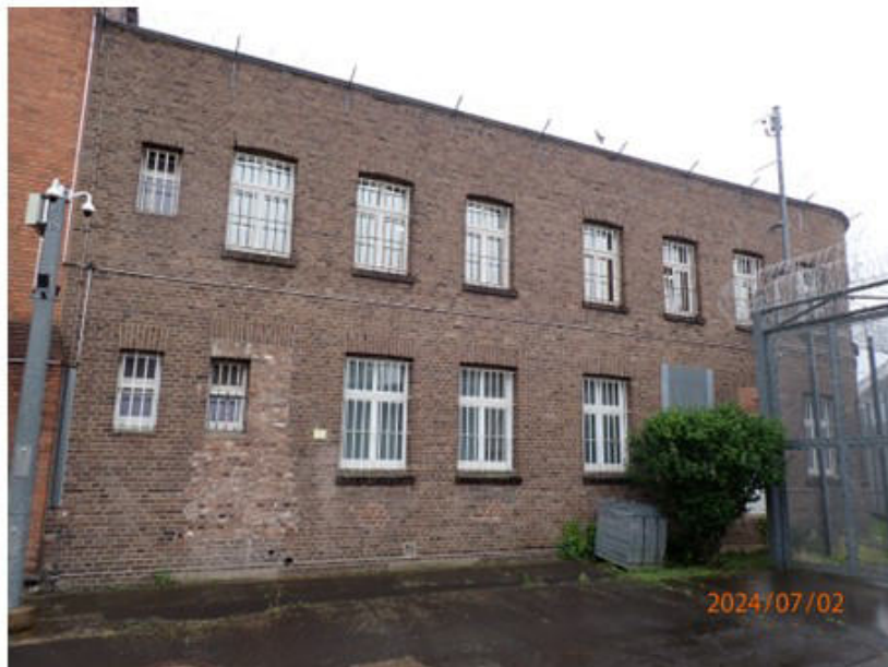
Ansicht Südost Fassade
