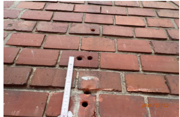
2. unversiegelte Bohrlöcher
