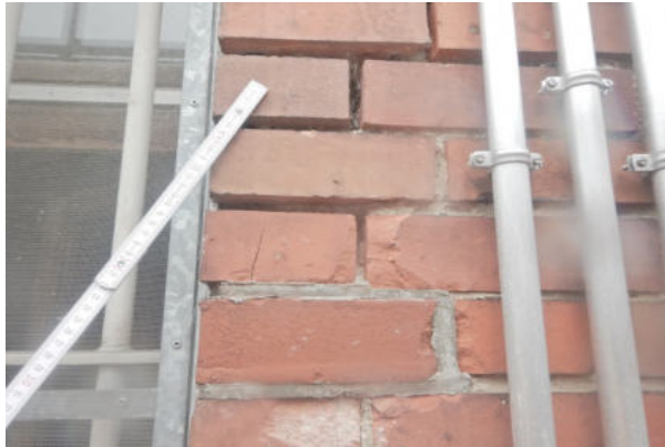
1. Abplatzung an Mörtelfuge
