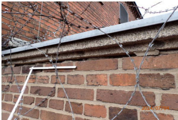
1. Mörtelfuge schadhaft
