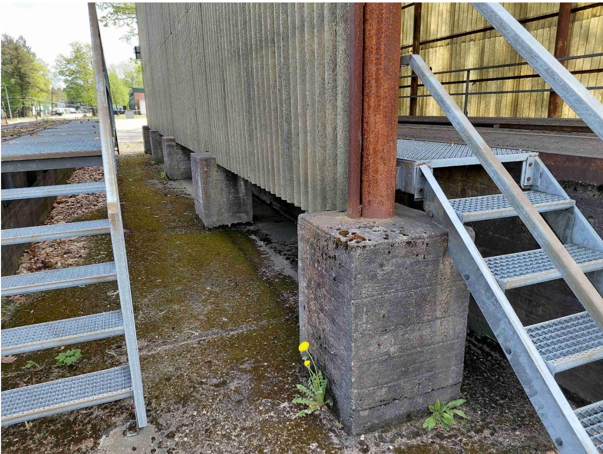
Abbildung 4: Betonfundamente Stahlstützen Überdachung
