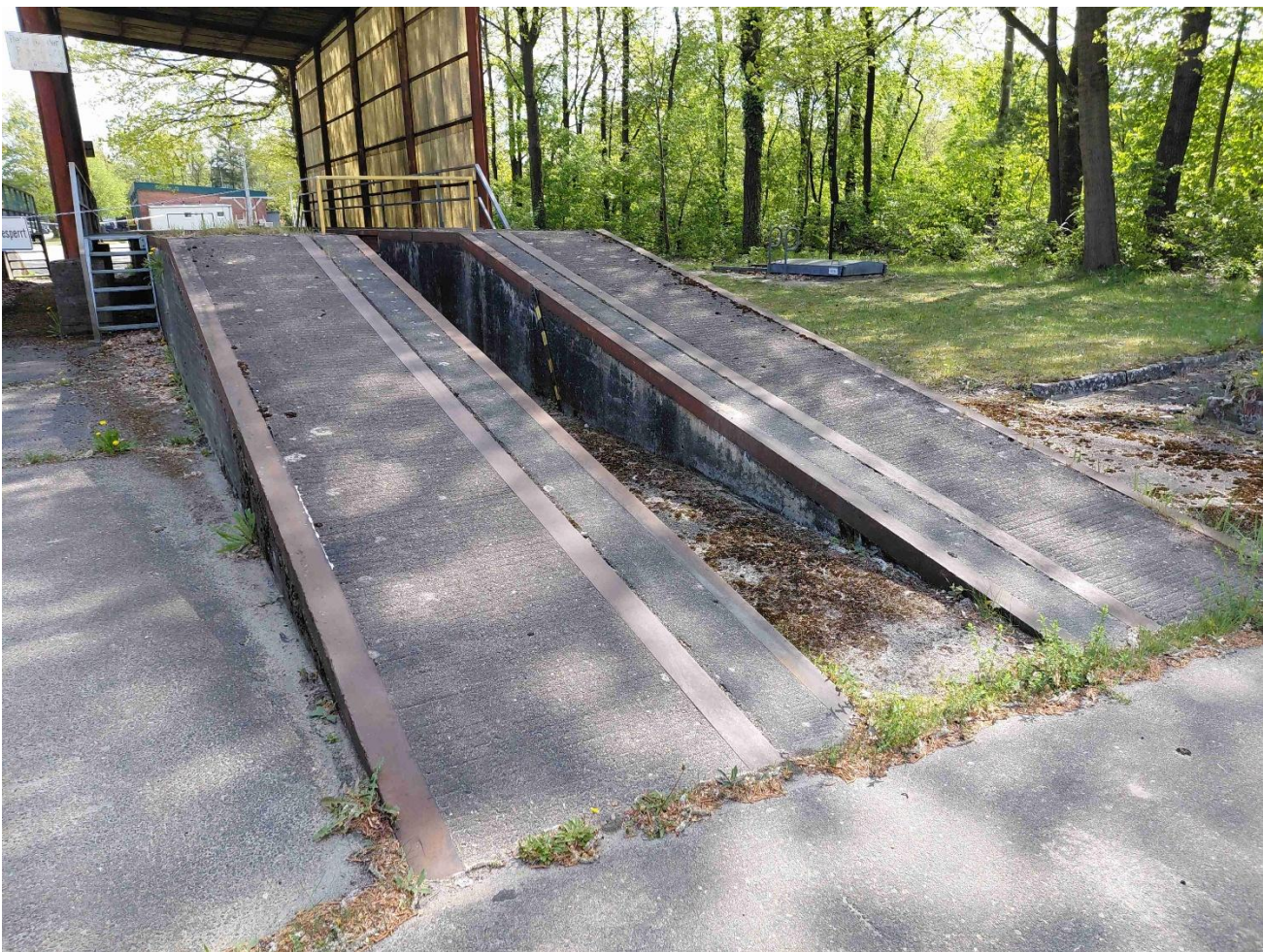
Abbildung 6: Rampenauffahrt Abschmier-/Wartungsrampe
