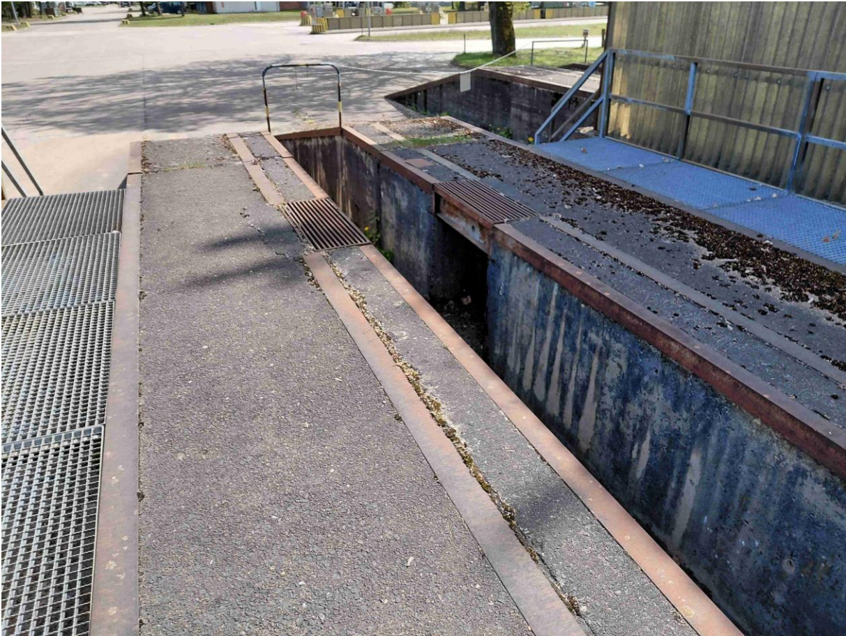
Abbildung 7: Abschmier-/Wartungsrampe
