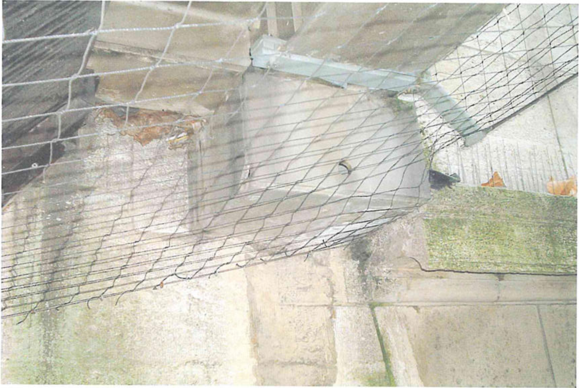
BILD 13: AUFLAGER ALTES RATHAUS KONSOLE RECHTS
