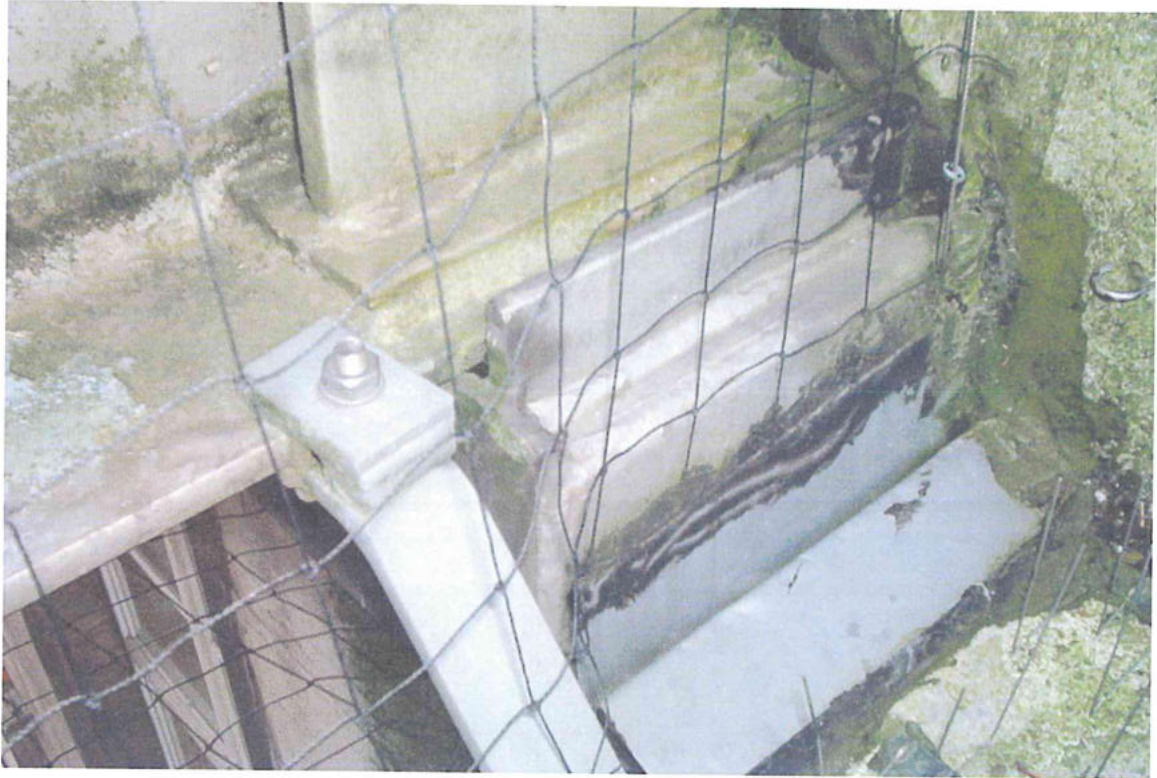
BILD 17: ANFLAGER ALTES RATHAUS KONSOLE RECHTS (OBERSEITIG)
