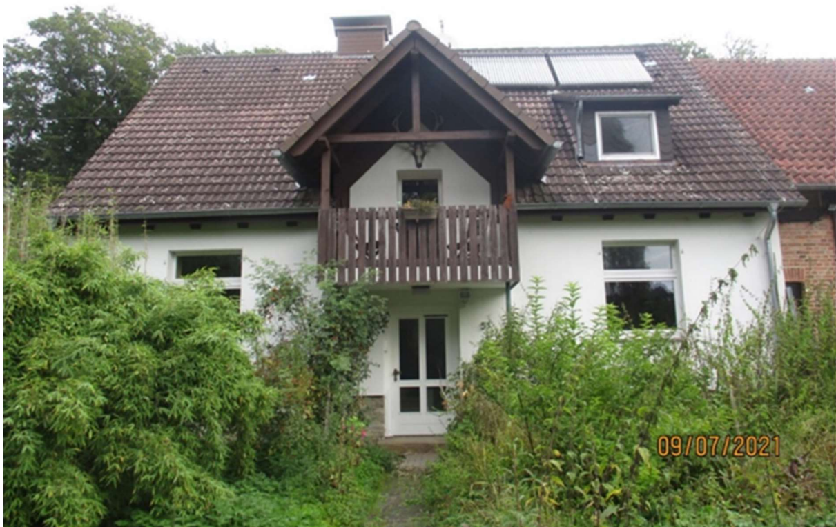
Bild: Frontansicht Wohnbereich des Forstdienstgehöfts Hakenberg
