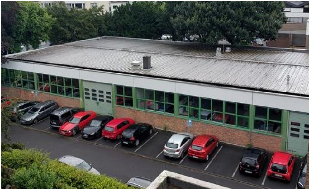
Abbildung 25: Dach mit Abluft- und Ansaugeinrichtung
