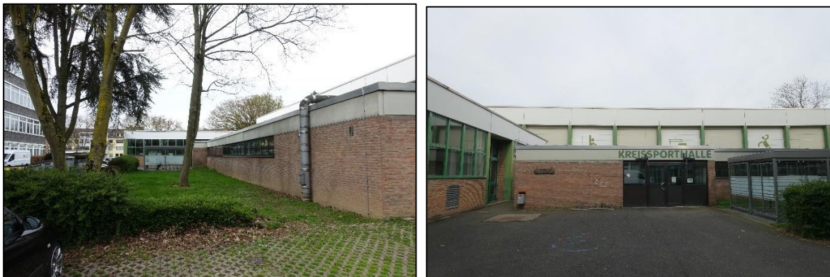
Abbildung 21: Südwestansicht mit Werkshalle im Hintergrund und Berufskolleg links // Südwestansicht Eingang Umkleiden
