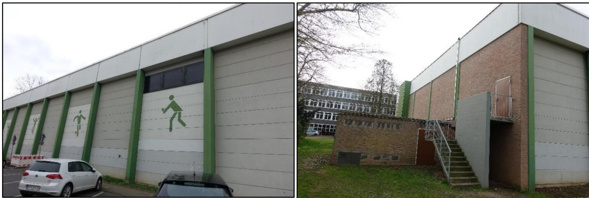
Abbildung 22: Außenwand Sporthalle mit Gasbetonfertigteilen // Außenwand verklinkert der Nebengebäude + Sporthalle (Stirnseite)
