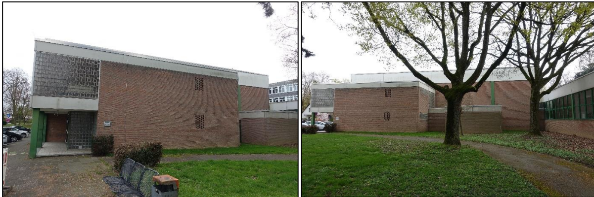
Abbildung 18: Nordostansicht Zuschauereneingang links, Stuhllager rechts
