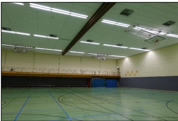
Abbildung 33: Zu- und Abluft in der Abhangdecke der Sporthalle // Leitungsführung entlang der Außenwände für die Sporthalle
