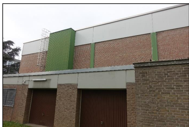
Abbildung 33: Zu- und Abluft in der Abhangdecke der Sporthalle // Leitungsführung entlang der Außenwände für die Sporthalle
