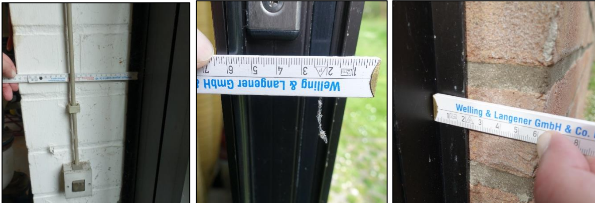
Abbildung 23: Wandaufbau Nebenräume mit Klinker
