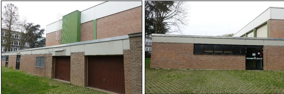
Abbildung 20: Südostansicht Geräteraum mit Garagentoren // Südostansicht Nebeneingang Flur
