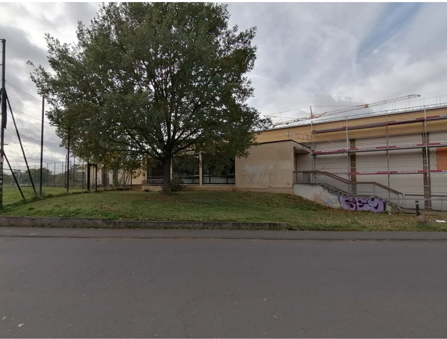
FOTOS BESTANDSBAUTEN (ABBRUCH)
