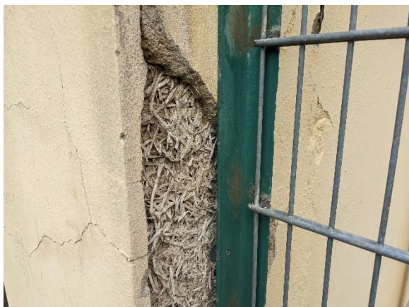
HWL-Platte in der Fassade
