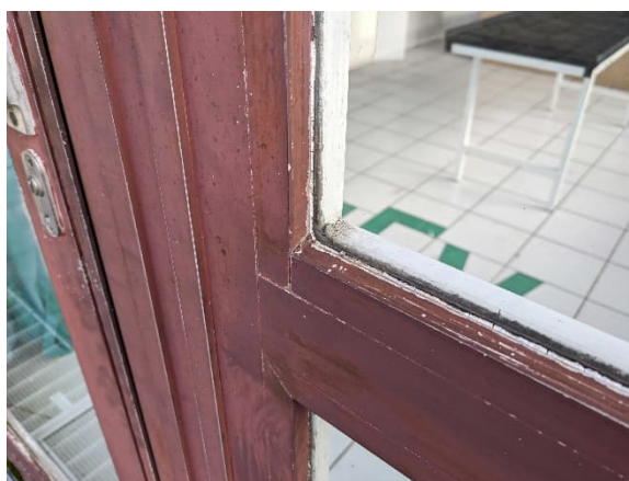
Fensterkitt asbesthaltig (Schiedsrichterraum)
