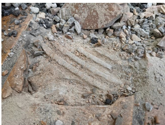
Fliesenspachtel asbesthaltig(EG, Umkleide)
