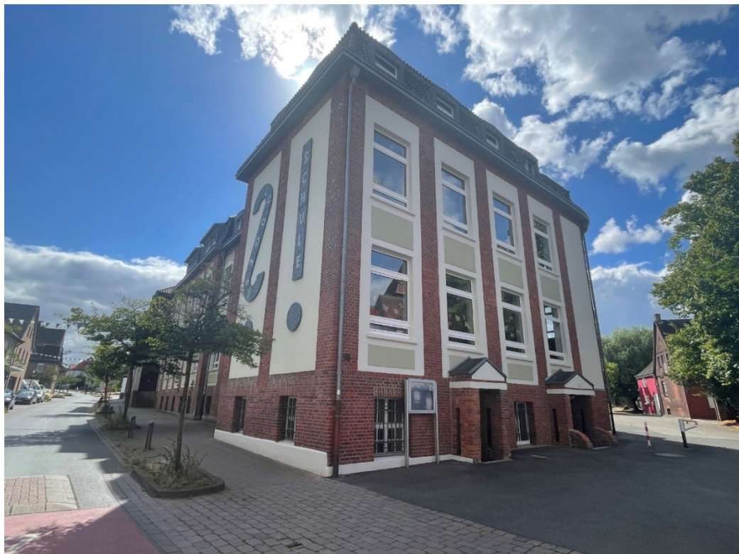
Straßenansicht Südkirchener Straße
