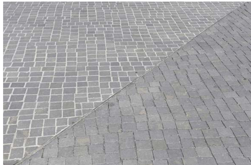
Basalt Kleinsteinpflaster gesägt, gebundene neben ungebundener Bauweise
