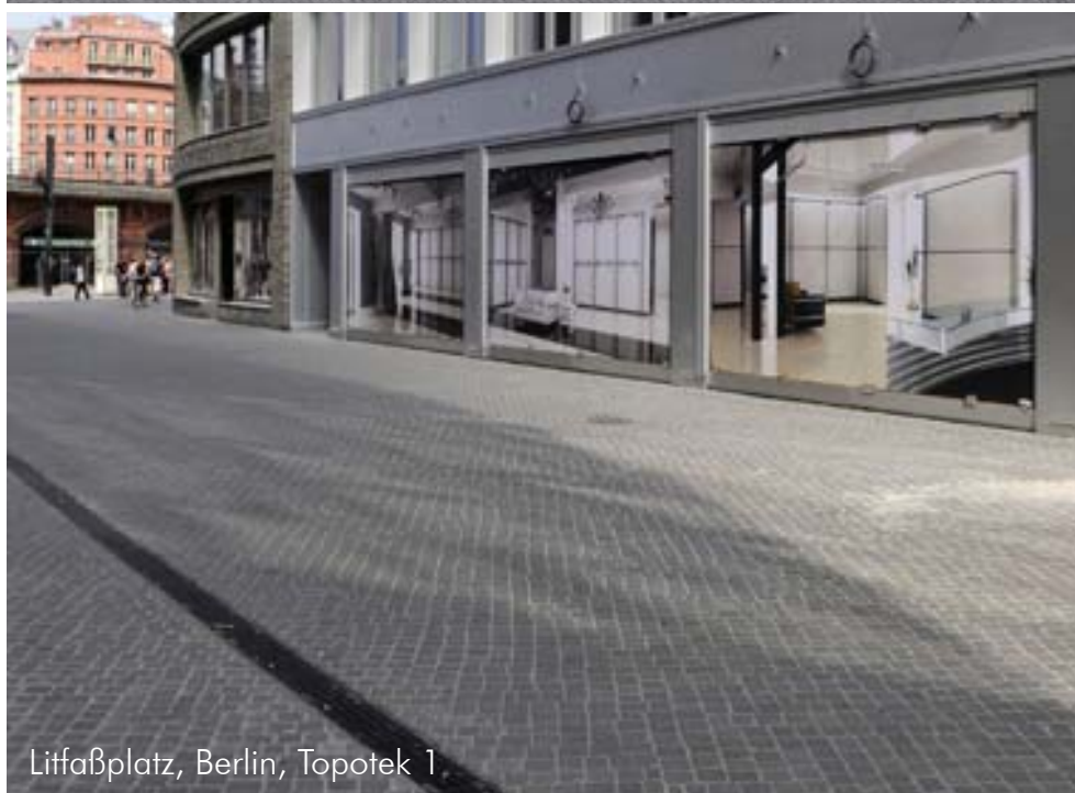
Basalt Kleinsteinpflaster gesägt, Passeverband, neben weißem Gußasphalt
