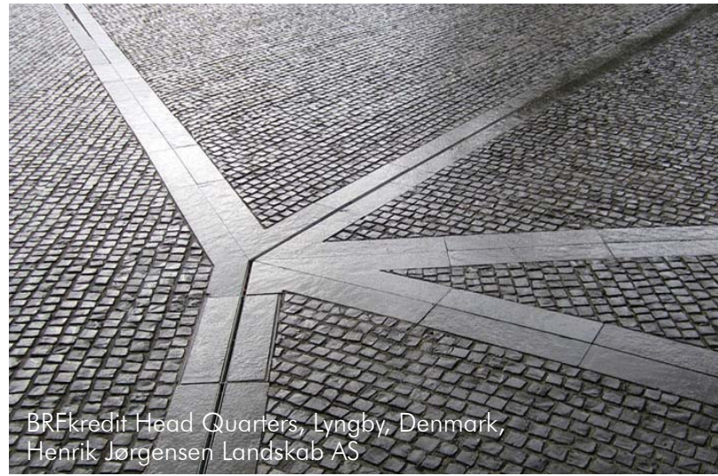
Basalt Kleinsteinpflaster gestockt, Reihenverband
