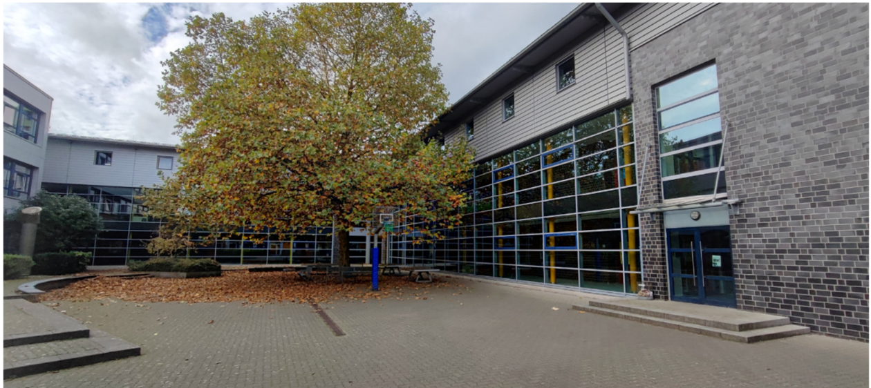
Innenhof mit Blick auf Bauteile B und G (rechts)
