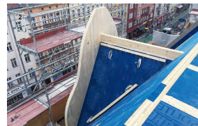
1 Aufzugschacht Weilmünster; © HOLZBAUWAGEN Pafften / 2 Ausstockung Deutsches Chorzentrum Berlin; © Zimmerwerkzeug Holzwerkzeug
