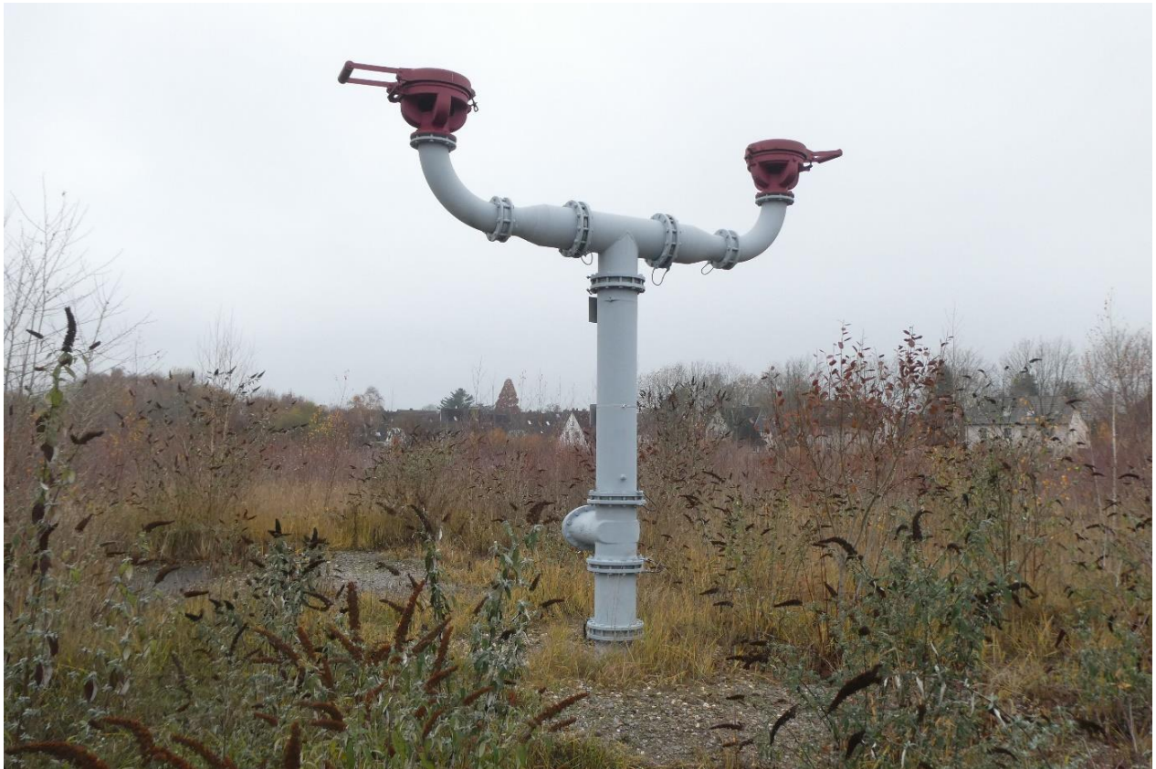
Abbildung 3: Be- und Entlüftungshaube des Schachtes Victoria 1 (Blick nach NE)
