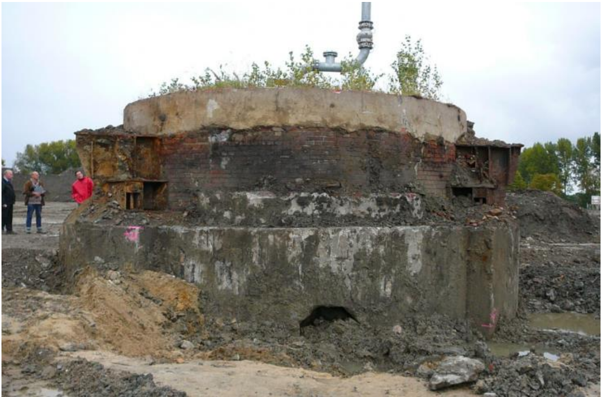
Abbildung 6: Schacht Ickern 3 im Jahr 2010 nach Freilegung und vor Beginn der Ertüchtigungsarbeiten /9/
