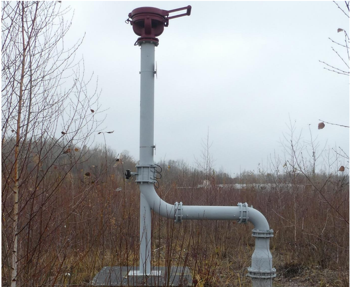
Abbildung 4: Be- und Entlüftungshaube des Schachtes Victoria 2
