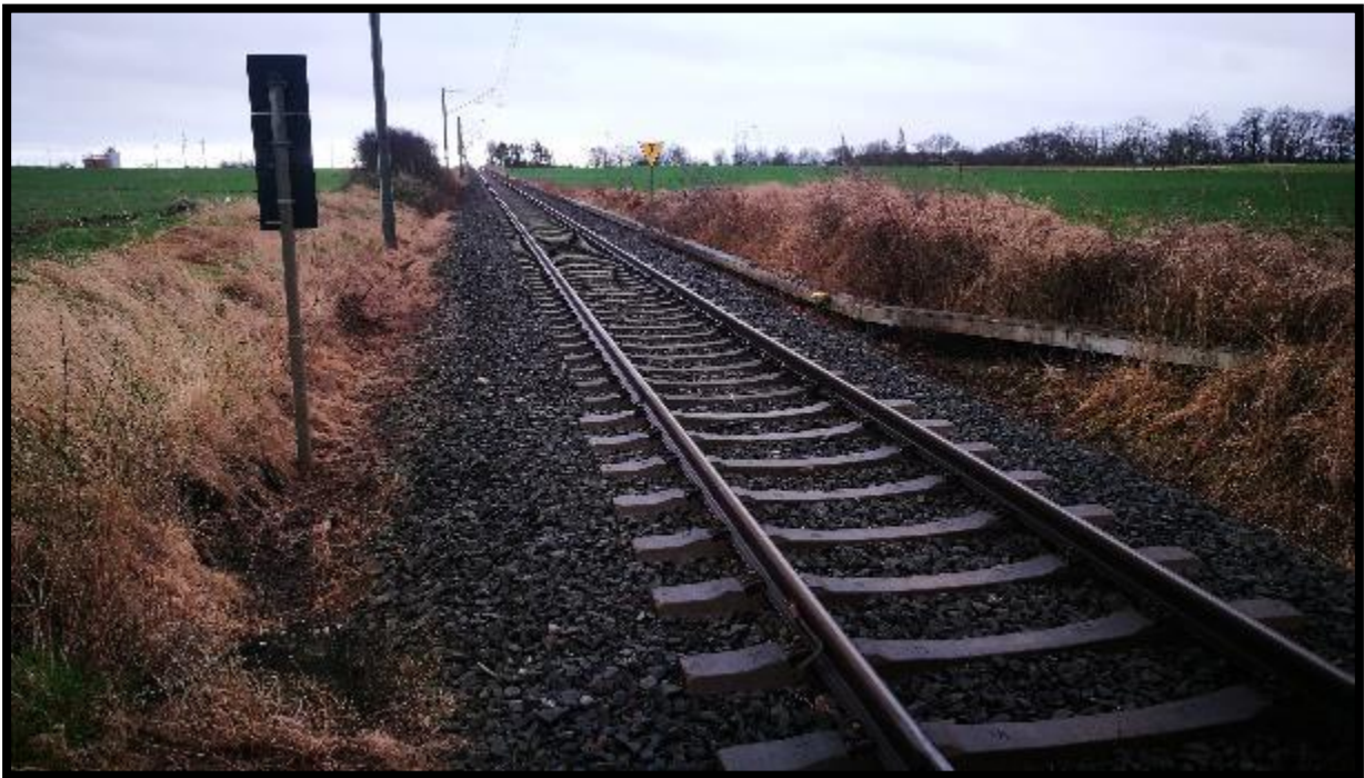
Bild oben: Sandgrube südwestlich des Plangebietes Bild unten: Bahngleise am Westrand des Plangebietes
