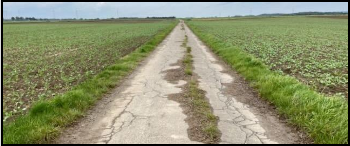
Abb. 18: Blick auf einen versiegelten Wirtschaftsweg im Plangebiet.
