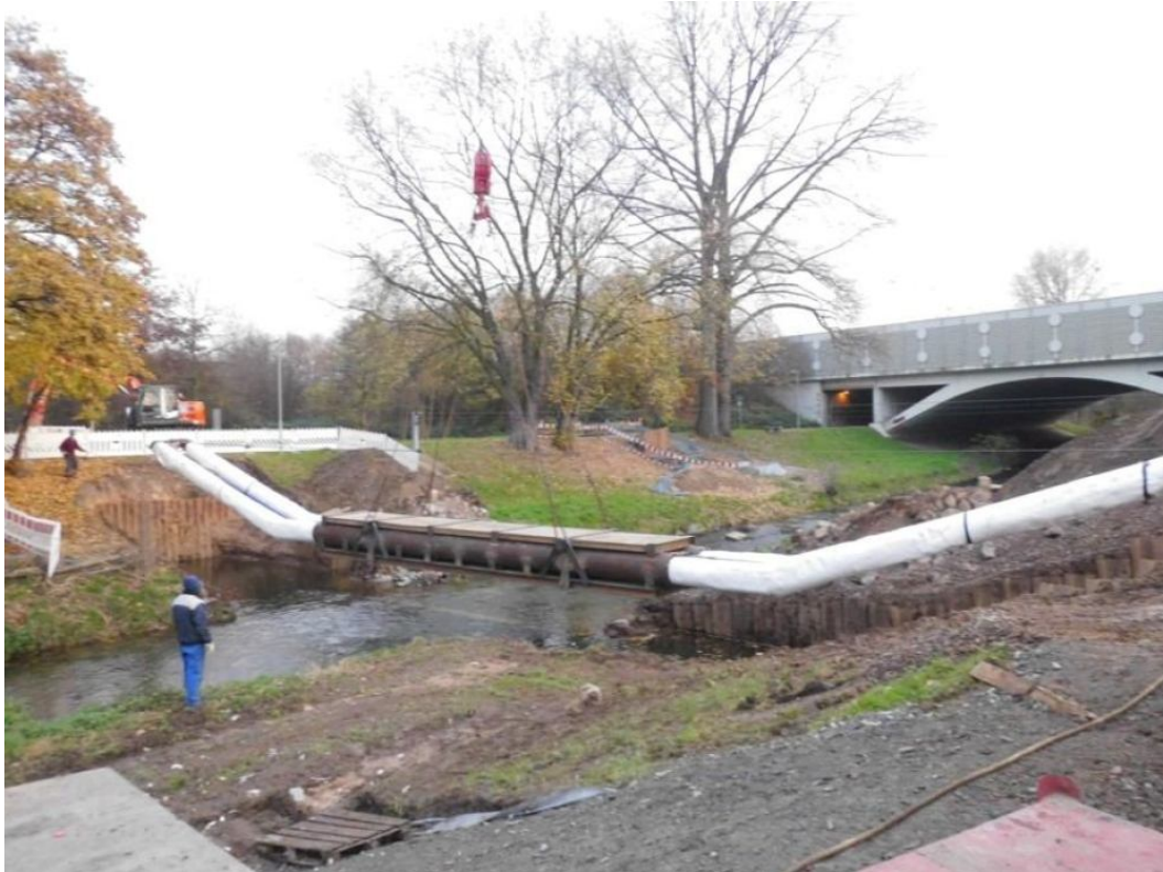
(01) Foto aus 2014: Das vormontierte „Düker-Bauteil“ zum Fernwärme-Düker „Flensburger Straße“ (im LEV-Manfort) hängt am Autokran und wird in seine „Düker-Baugrube“ abgesenkt
