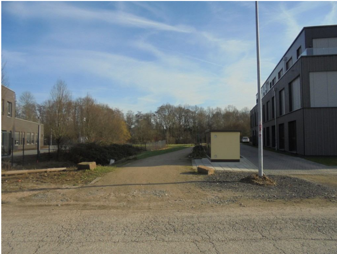
(17) Blick von der Johannes-Kepler-Straße Richtung Nordosten in den Geh- und Radweg, der dort mit Stahlplatten zur temporären Baustraße ertüchtigt werden soll (Foto vom 29.01.2024)
