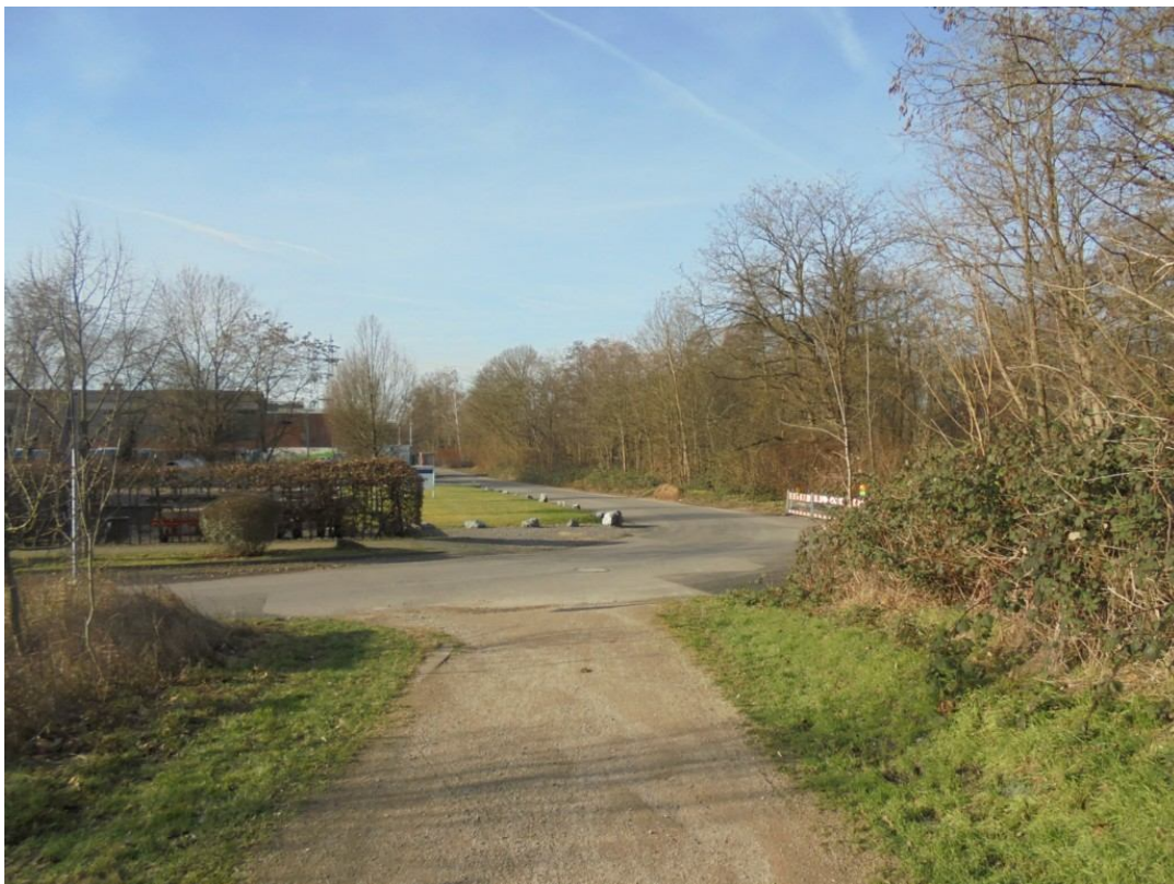
(16) Blick Richtung Westen auf die geplante Anschluss-Stelle an den Bestand in der (asphaltierten) Friedrich-Sertürner-Straße (Foto vom 29.01.2024)
