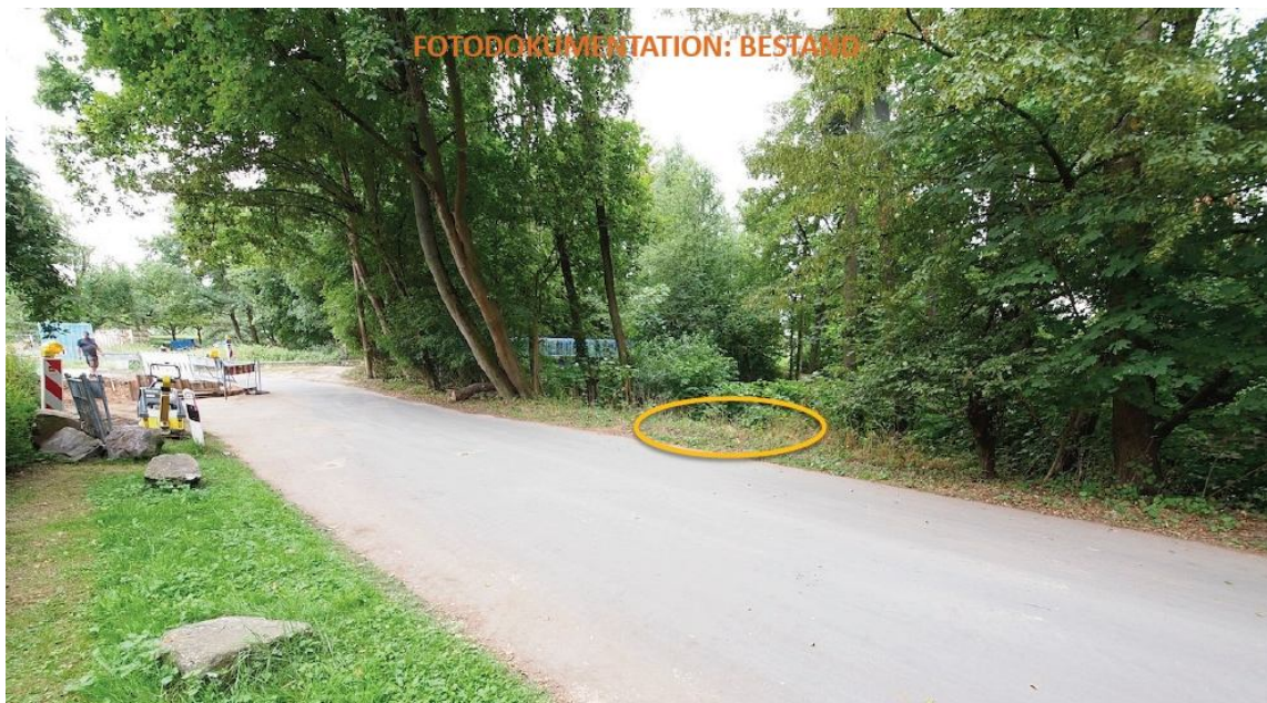
(04) Ebenfalls aus 2023 und der Fotodokumentation: Nördlicher Uferbereich an der beabsichtigten Querungsstelle, Straße „Schlebuschrath“ mit Restarbeiten am derzeitigen Leitungsbestand (Bake, Absperrung, Rüttelplatte)
