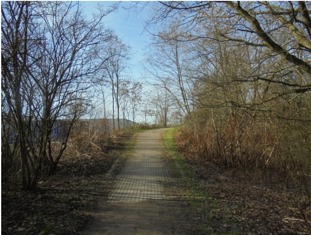
(13) Blick Richtung Westen, etwa 38m einer Wegestrecke mit ca. 6% Gefälle tragen Rechteckpflaster im Läuferverband (Foto vom 29.01.2024)
