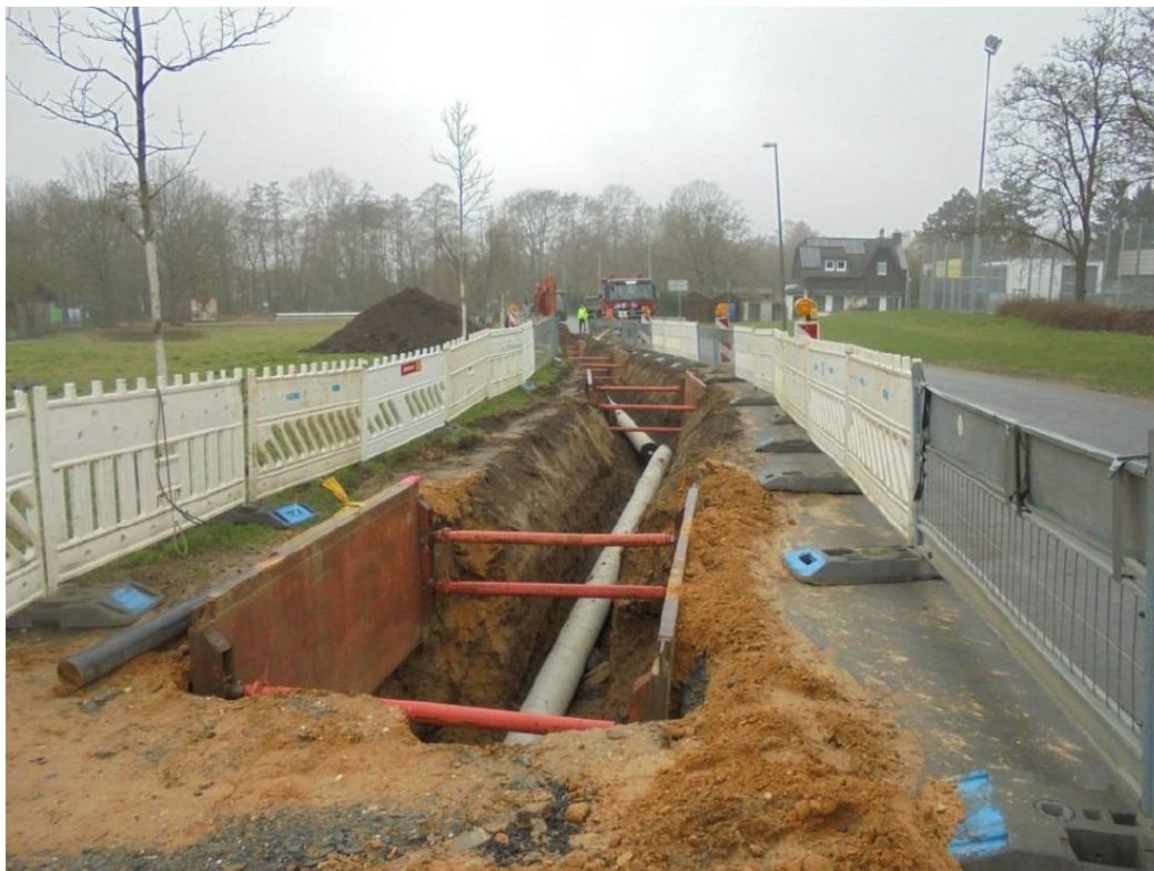
(02) Foto aus März 2023: Leitungsgraben südlich der Straße „Schlebuschrath“
