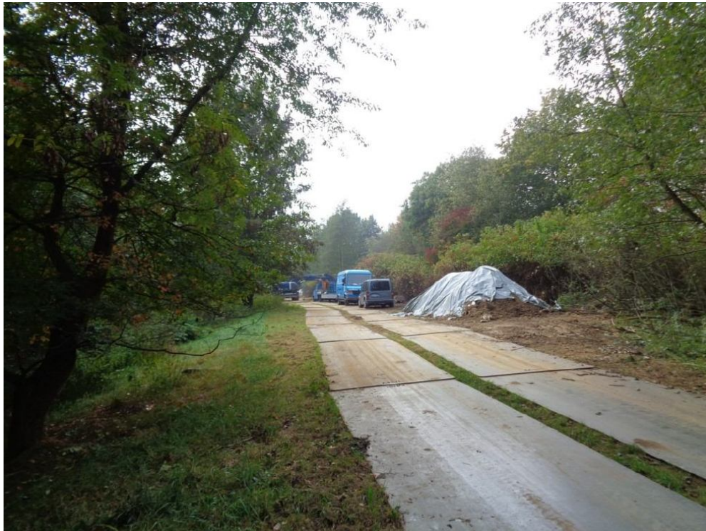
Beispiel einer temporären Baustraße (aus Stahlplatten der MSL GmbH)
