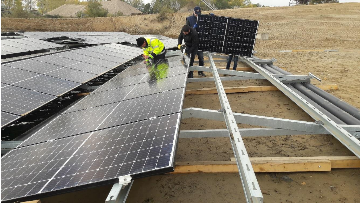
Abbildung 6 Montage eines Ost-West-Giebels mit Reling an der Außenseite; Quelle: Christian Kirschning SolarAnts
